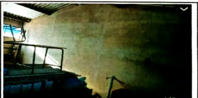
Nº 6 MODULO 2 Repello + cernido en muro interior (block)
