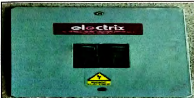
Foto 5: MODULO sustitucion de tablero y flipones
