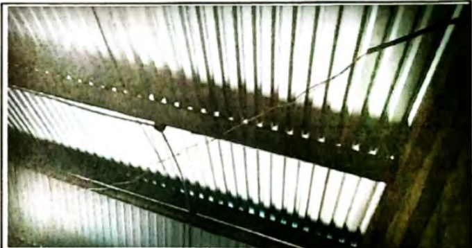
Foto 4: MODULO sustitución de ducto eléctrico + accesorios
