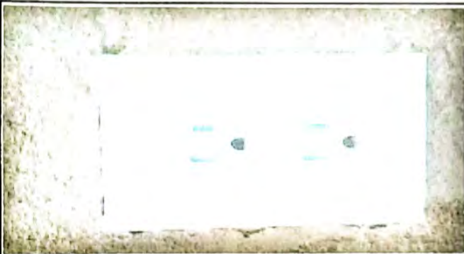
Foto 3: MODULO 2 Sustitución de tomacorriente
