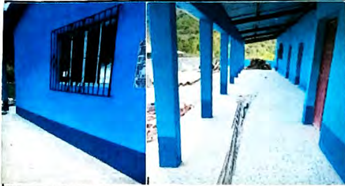
Foto 13: PINTURA GENERAL pintura en muro exterior (block)
