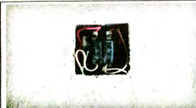
Foto 5: MODULO sustitución de tablero y flipones
