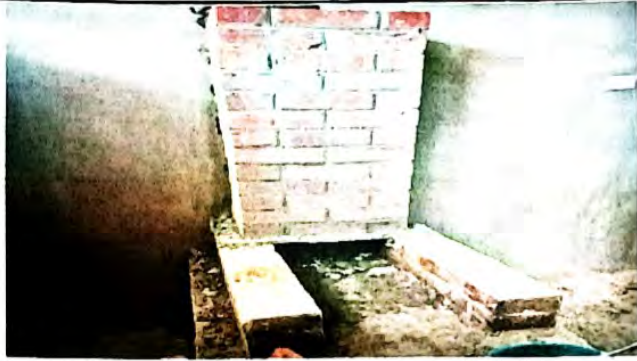
Foto 7: MODULO 2 sustitución de estufa mejorada y chimenea de ladrillo
