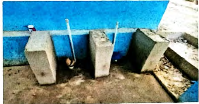
Foto 8: AREAS EXTERIORES suministro e instalación de lavamanos
