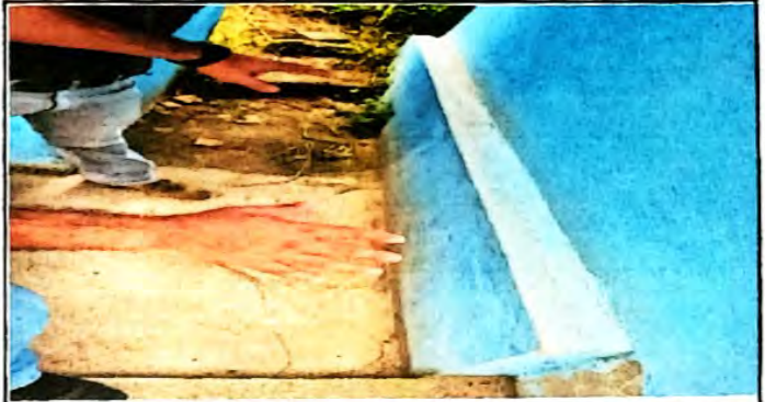
Foto 8: AREAS EXTERIORES suministro e instalación de lavamanos
