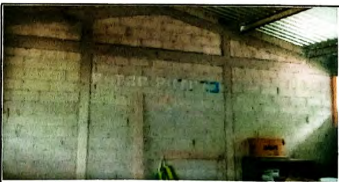
Nº 6 MODULO 2 Repello + cernido en muro interior (block)
