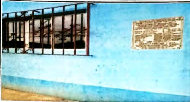
Foto 13: PINTURA GENERAL pintura en muro exterior (block)
