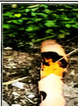
Foto 2: MODULO 2 sustitución de tubería principal de agua pluvial.
