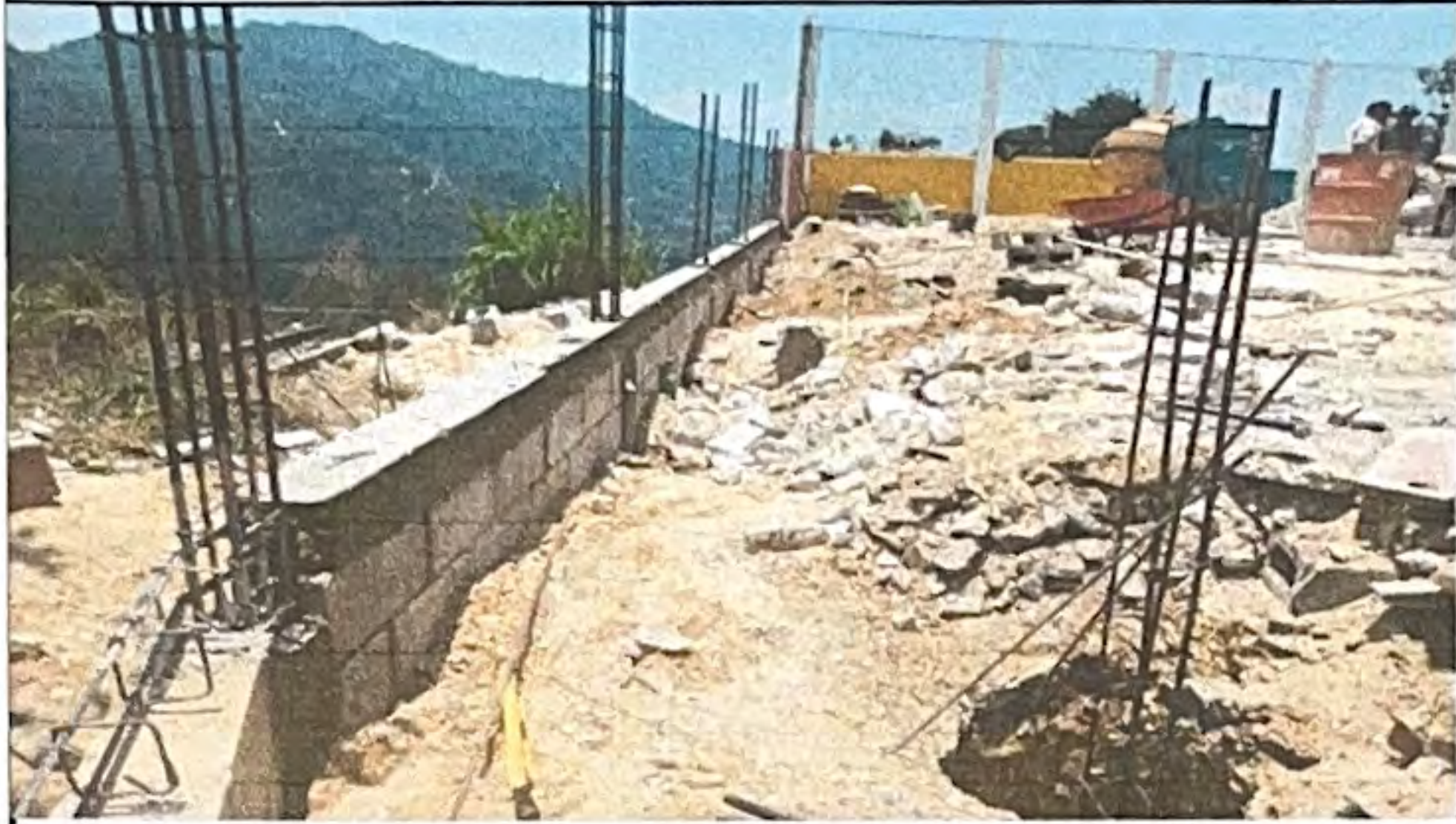
Foto 1: Modulo 1. Reparación de muro perimetral de block.
