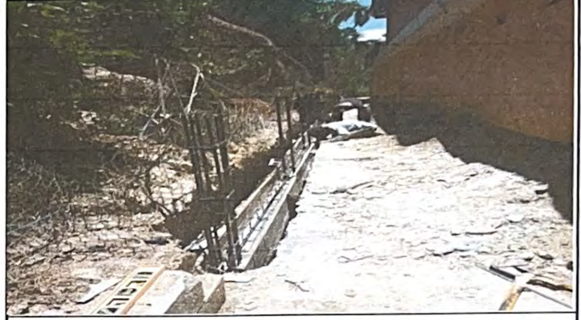
Foto 2: Modulo 1. Reparación de muro perimetral de block con tubo hg y malla galvanizada, soleras intermedias y columnas
