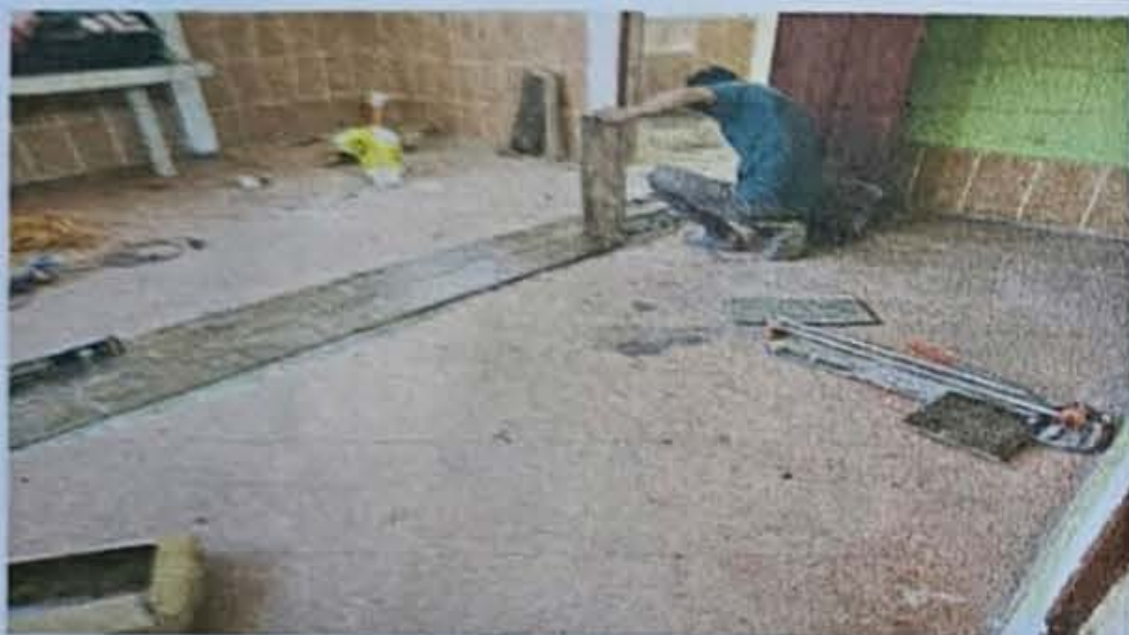
Foto 3: sustitucion de piso
