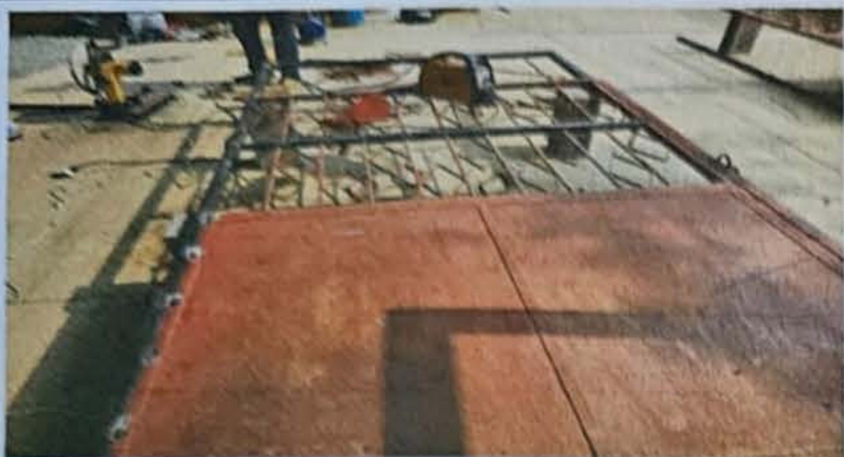
Foto 1: reparación, pintura y chapa de portón
