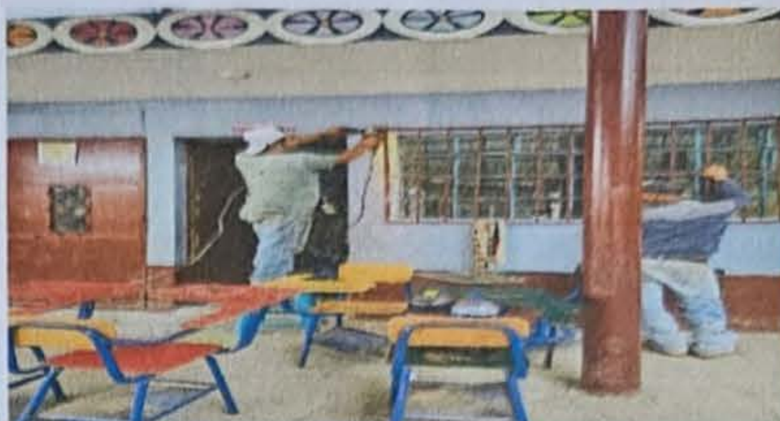
Foto 2: reparación de valcón
