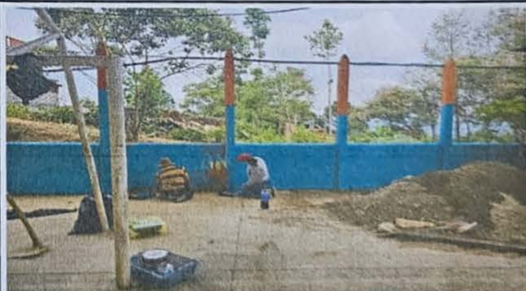
Foto 6: remozamiento a pared aplicando pintura
