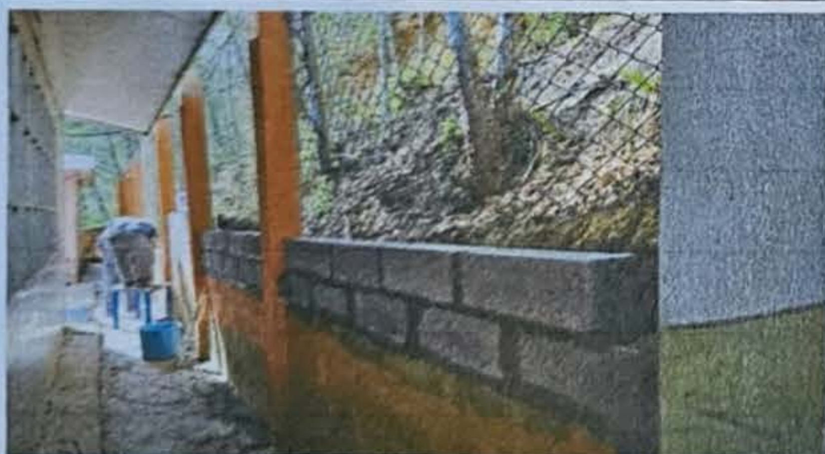
Foto 5: reparacion de muro perimetral
