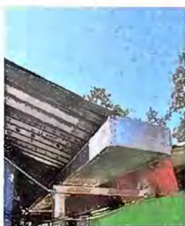
Foto 5: Modulo 1: Sustitución de canal de metal
