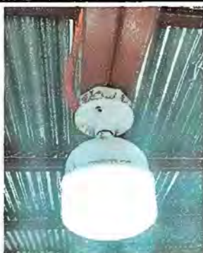
Foto 9: Modulo 1: Sustitución de focos ahorradores
