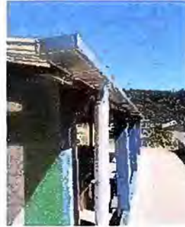
Foto 14: Modulo 2: Sustitución de canal de metal
