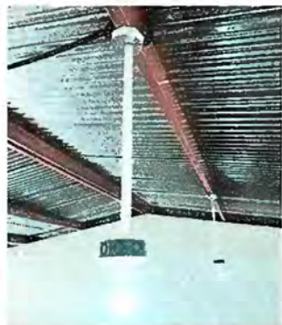
Foto 7: Modulo 1: Reparación de cableado eléctrico
