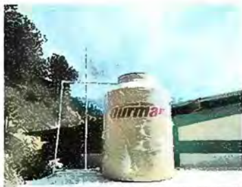
Foto 11: Modulo 1: Sustitución de depósito de agua 1100 lt
