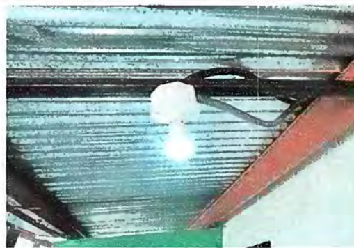
Foto 8: Modulo 1: Sustitución de ducto eléctrico + accesorios
