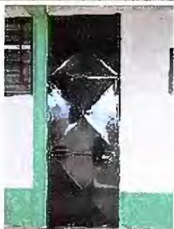
Foto 3: Modulo 1: Mantenimiento a estructura de puerta (lijado, cambio de tubo, cepillado, sujeciones, aplicación de pintura)
