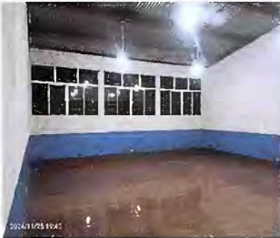
Foto16:Pintura general: Pintura en muros exteriores e interiores
