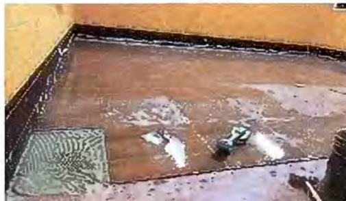
Foto 4: Modulo 1: Sustitución de piso cerámico
