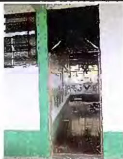
Foto 3: Modulo 1: Mantenimiento a estructura de puerta (lijado, cambio de tubo, cepillado, sujeciones, aplicación de pintura)
