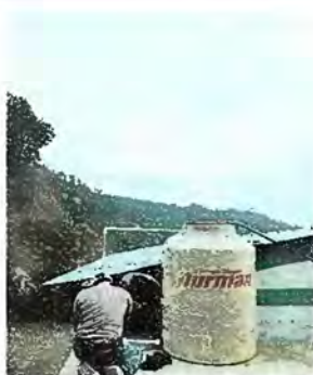
Foto 11: Modulo 1: Sustitución de depósito de agua 1100 lt
