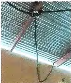
Foto 7: Modulo 1: Reparación de cableado electrico
