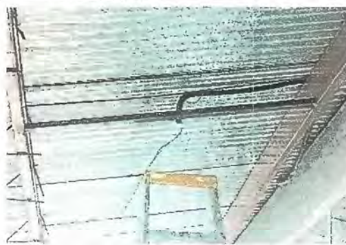
Foto 8: Modulo 1: Sustitución de ducto eléctrico + accesorios
