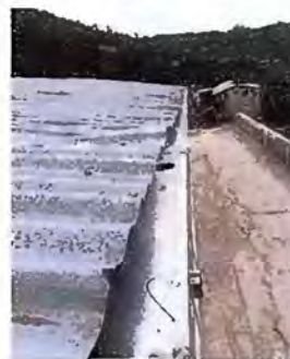
Foto 14: Modulo 2: Sustitución de canal de metal
