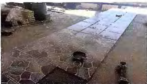
Foto 13: Modulo 2: Sustitución de piso cerámico
