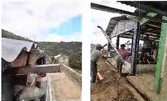
Foto 6: Modulo 1: Sustitución de bajada de agua pluvial de metal por tubo PVC 3"
