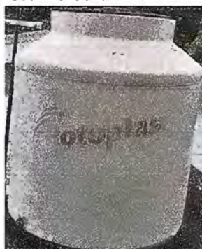
Foto 11: Modulo 1: Sustitución de depósito de agua 1100 lt
