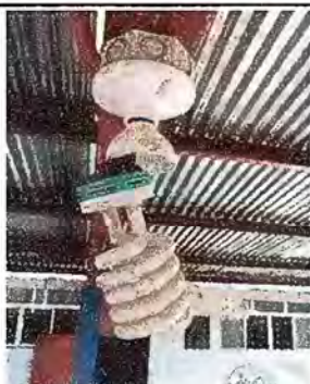
Foto 9: Modulo 1: Sustitución de focos ahorradores
