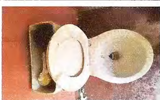
Foto 12: Modulo 1: Sustitución de accesorios inodoro (contra llave, tubo de abasto y tanque)
