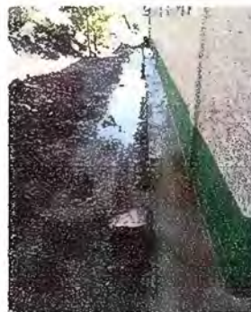
Foto 2: Modulo 1: Reparación de cuneta de concreto
