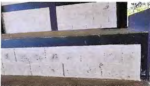
Foto 13: Modulo 2: Sustitución de piso cerámico
