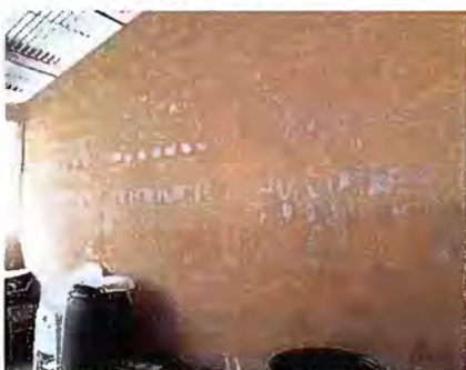
Foto 16: Pintura general: Pintura en muros exteriores e interiores
