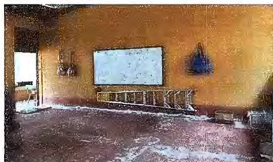
Foto 4: Modulo 1: Sustitución de piso cerámico
