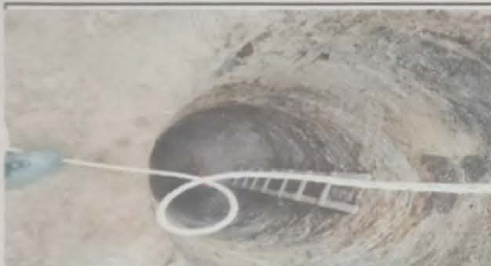
Foto 15: Reparación de fosa séptica
