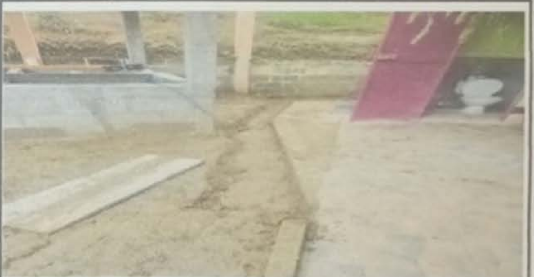
Foto 10: Reparación de cunetas de concreto
