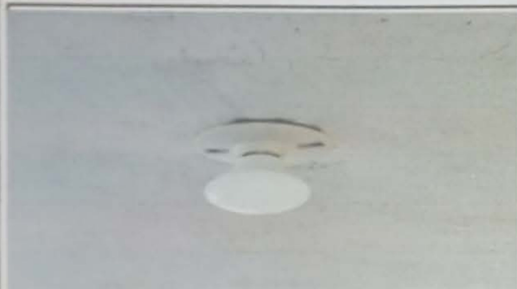
Foto 3: Sustitución de focos ahorradores
