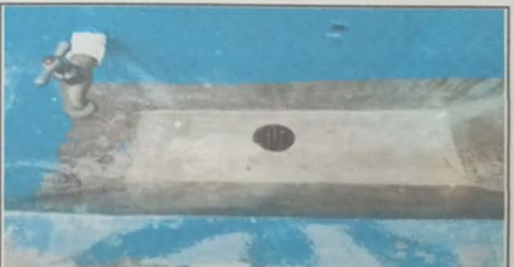
Foto 12: Sustitución de lavamanos
