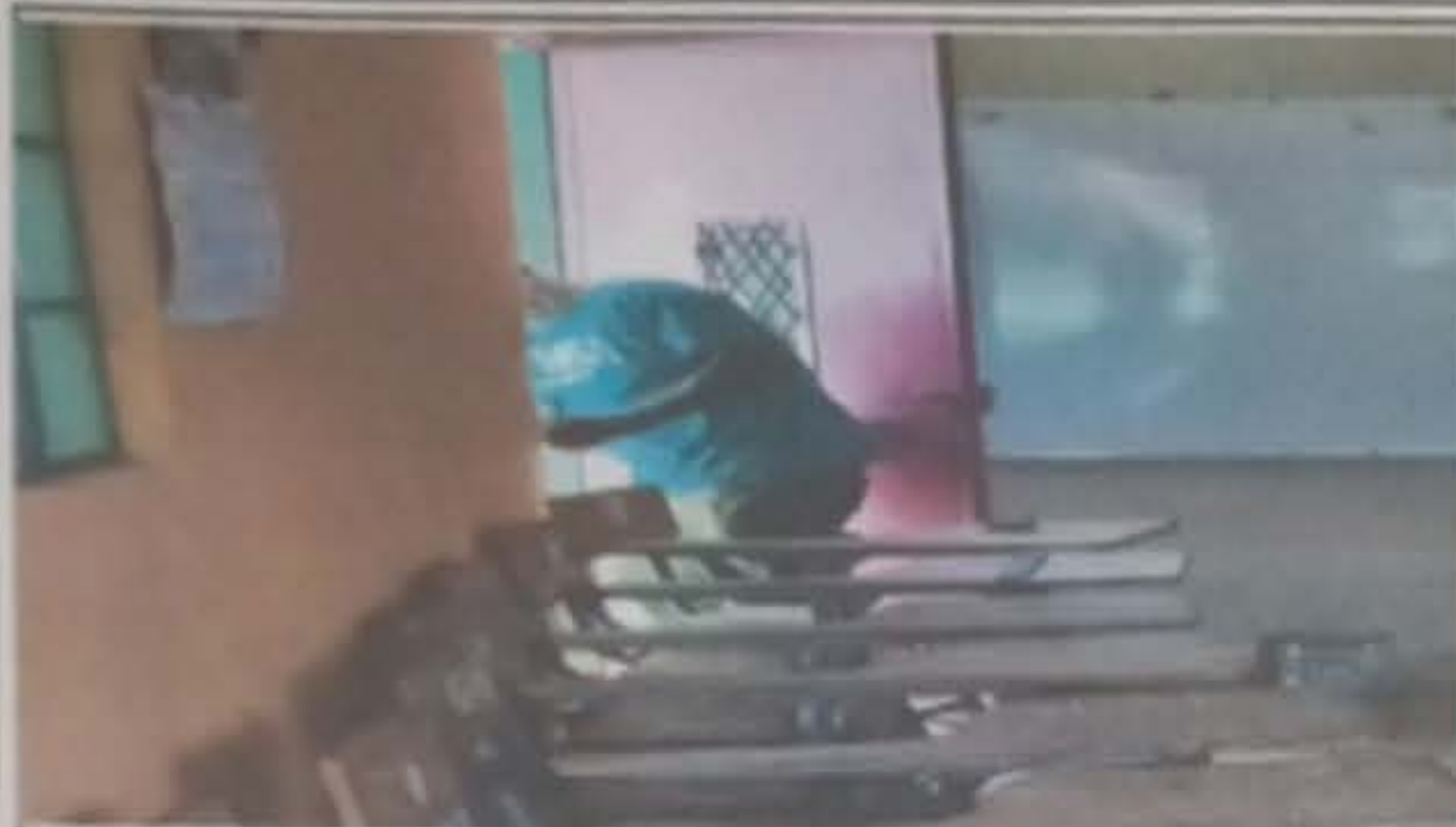
Foto1: Mantenimiento en puertas de metal
