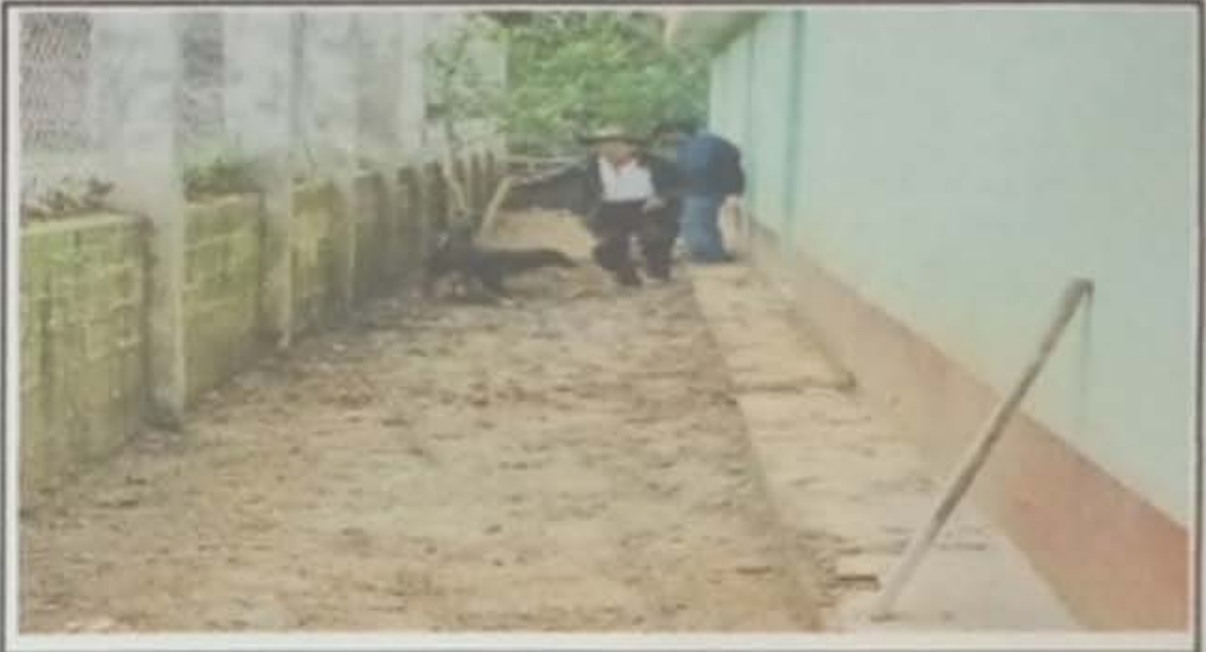
Foto 8: Reparación de torta de concreto
