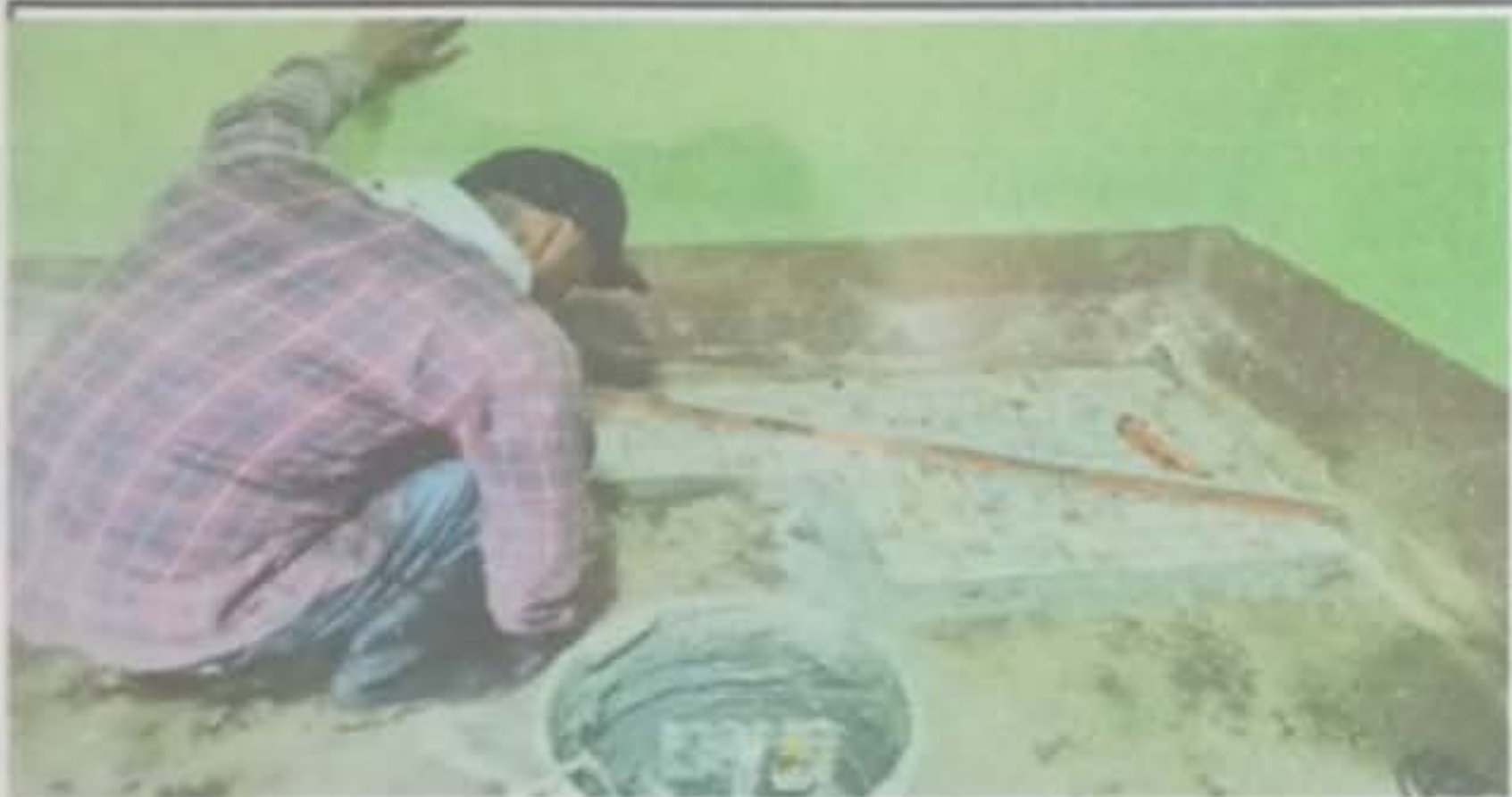
Foto 9: Reparación de piso cerámico
