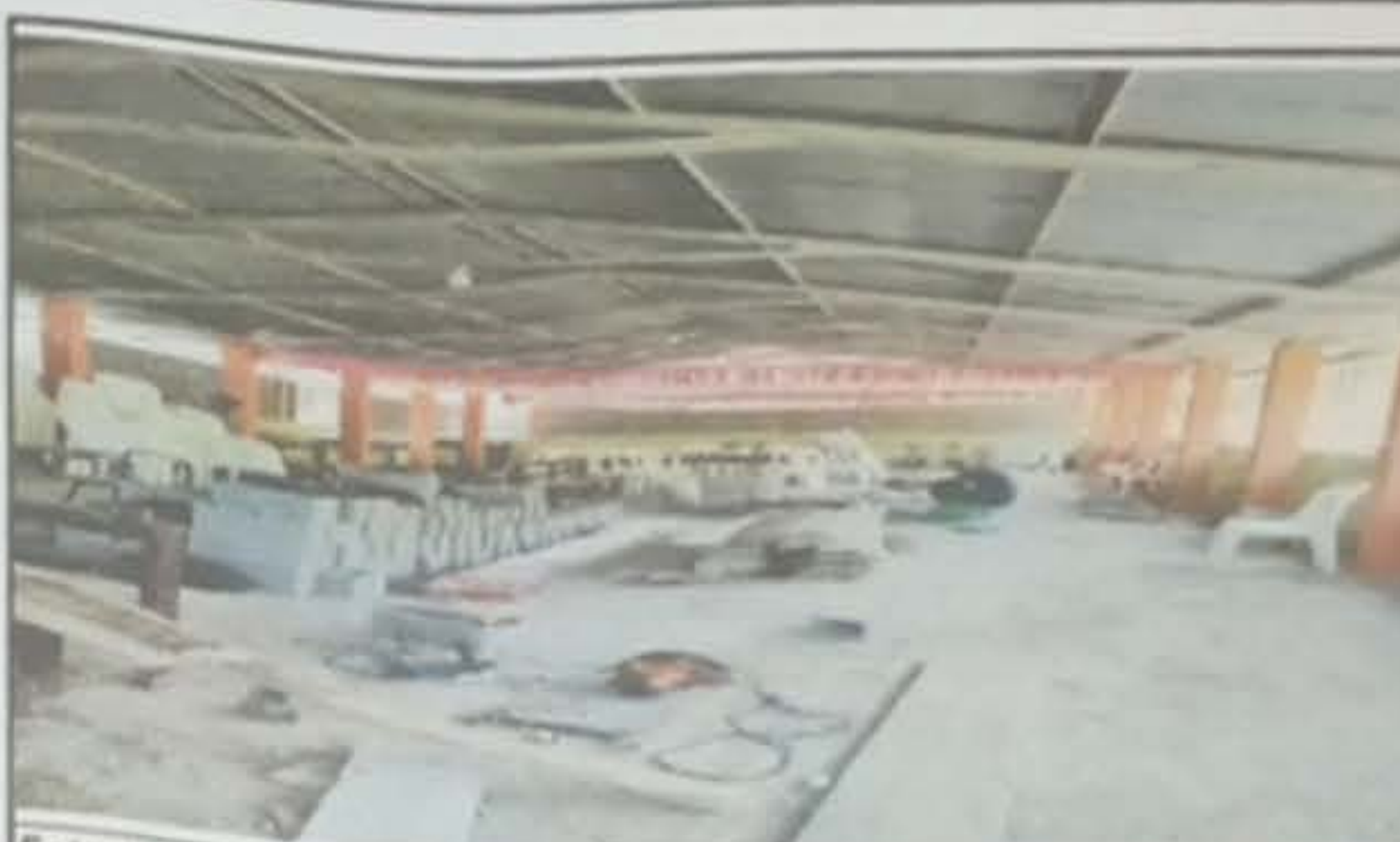
Foto 4: Reparación de muro perimetral salon de block
