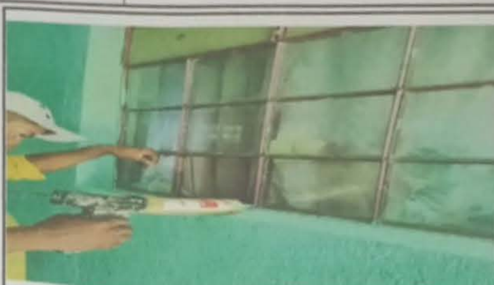
Foto 2: Sustitución de vidrios
