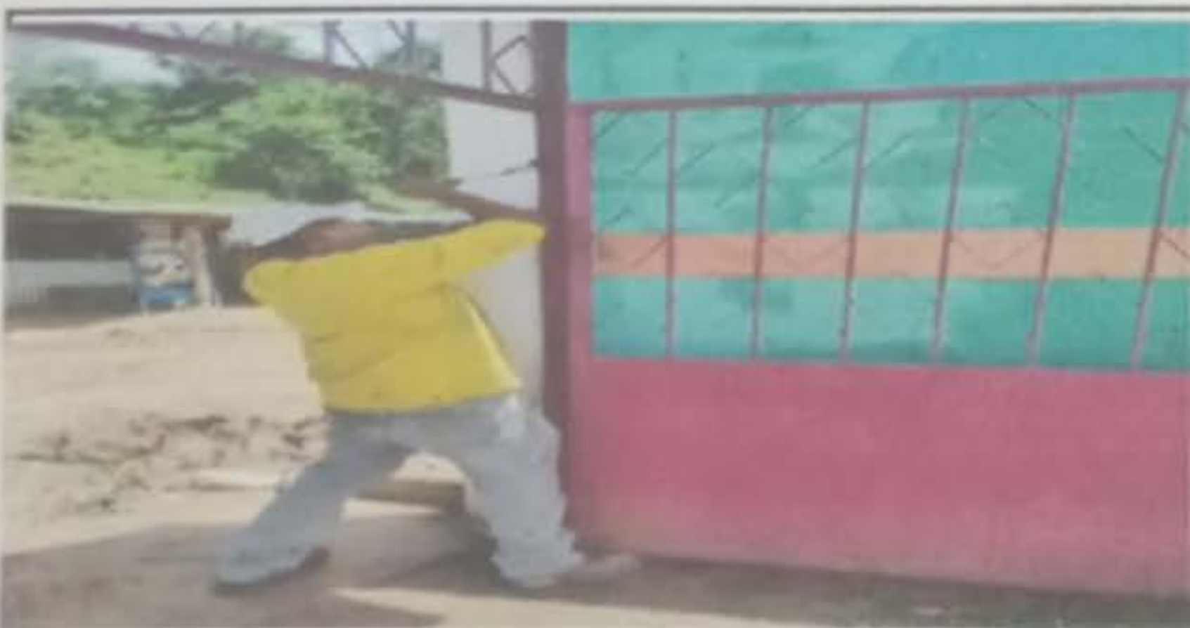
Foto 11: Mantenimiento en porton de metal
