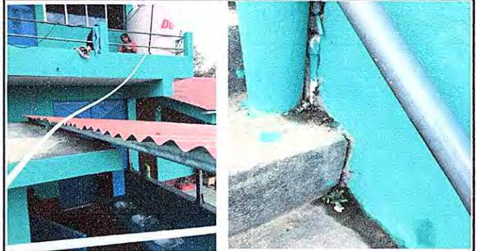
Foto 13: MODULO 3. Sustitución de tubería línea principal
