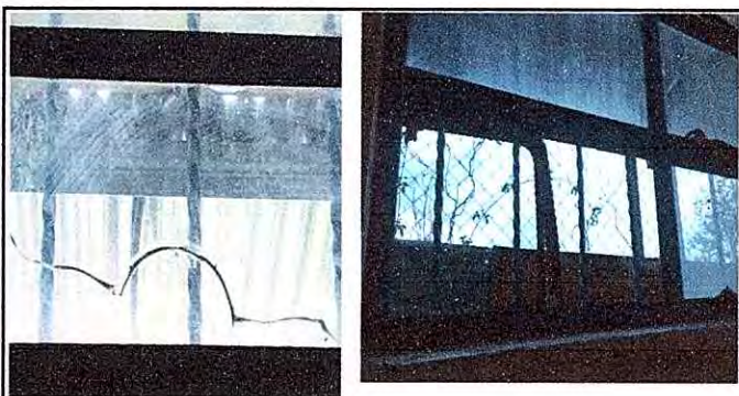
Foto 10: MODULO 2 Sustitución de vidrios
