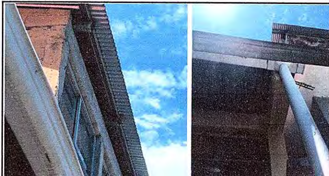
Foto 8: MODULO 2. Sustitución de canal de pvc por metal, Sustitución de bajada de agua pluvial de PVC
