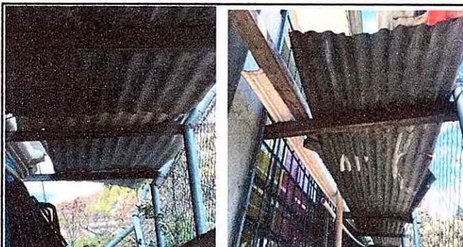
Foto 9: MODULO 2. Sustitución de estructura de soporte de madera, por metal. Sustitución de lámina, por lámina troquelada aluzinc calibre 26.
