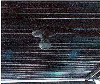
Foto 13: MODULO 2 : Sustitución de lamparas tipo LED
