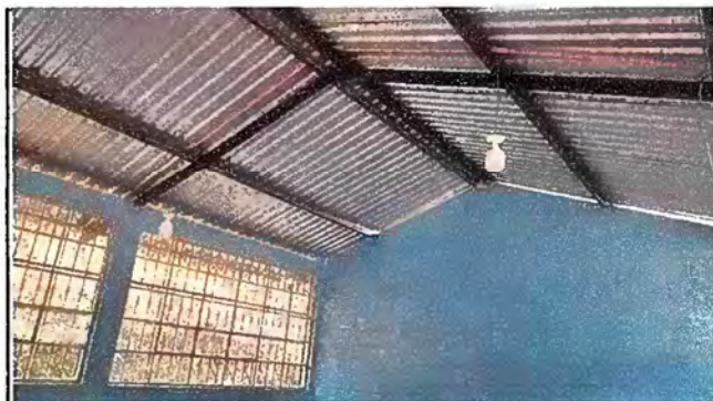
Foto 4: instalacion de unidad de luz
