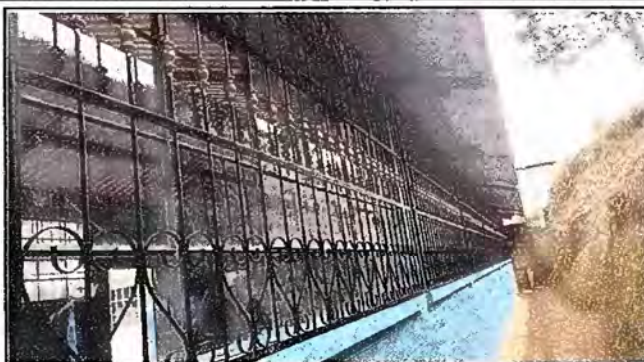
Foto 2: suministro e instalacion de balcon de metal
