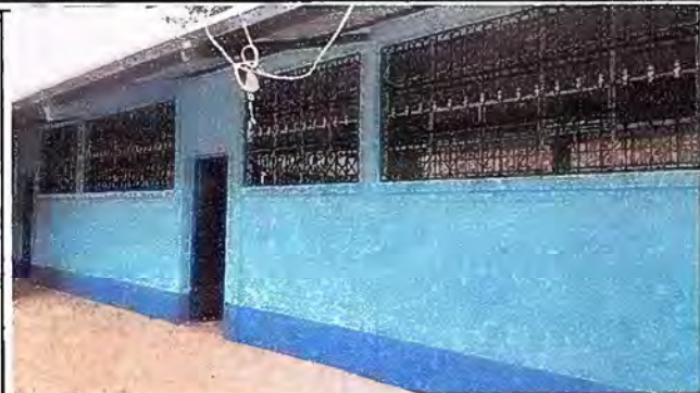
Foto1: suministro e instalacion de balcon de metal
