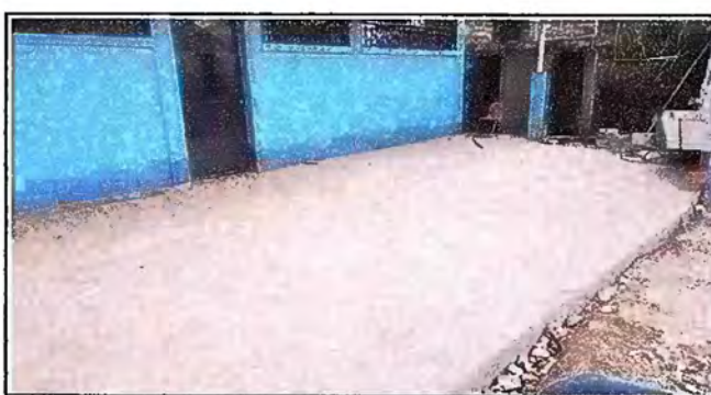
Foto 6: Reparacion de planchas de concreto de patio
