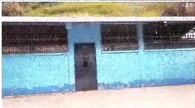
Foto1: suministro e instalacion de balcon de metal
