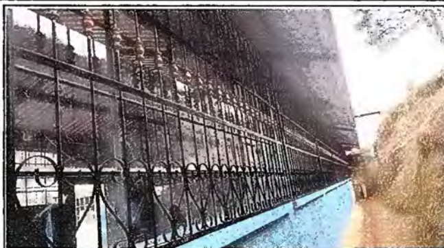
Foto 2: suministro e instalacion de balcon de metal
