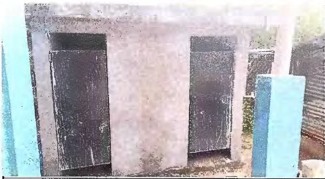
Foto 5: sustitucion de inodoro
