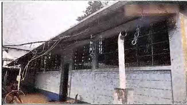
Foto1: suministro e instalacion de balcon de metal
