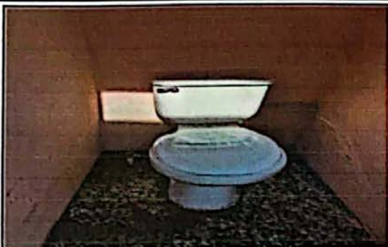
Foto 7: Modulo 2 sustitucion de inodoros
