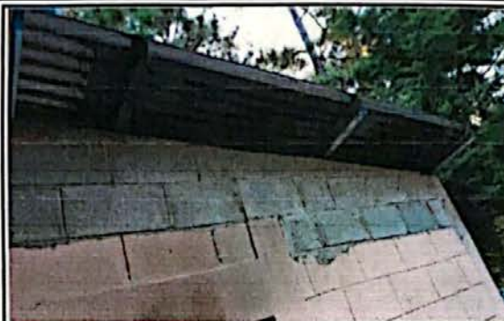
Foto 8: modulo 3 levantamiento de molinetes
