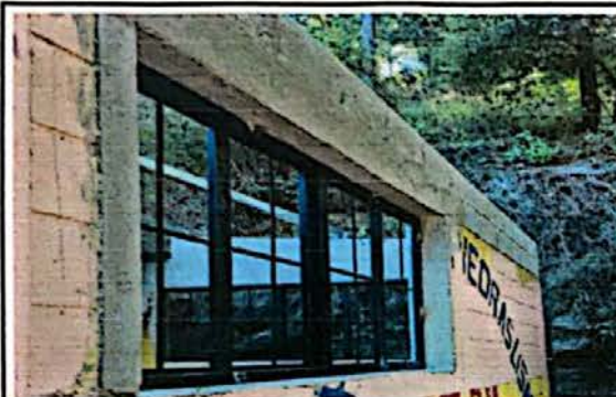
Foto 9: modulo 3 Levantamiento de ventanas
