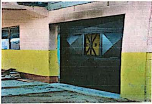
Foto 6 modulo 2 sustitucion de puerta de metal
