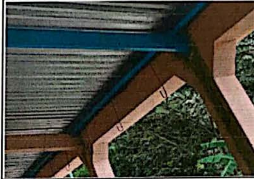
Foto 2: Modulo 1 mantenimiento de estructura de soporte
