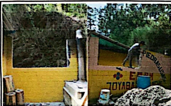
Foto 9: modulo 3 Levantamiento de ventanas
