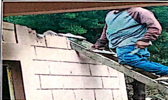
Foto 8: modulo 3 levantamiento de mojinetes
