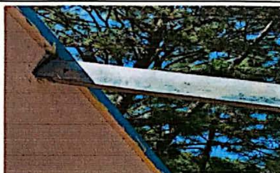
Foto 2: Modulo 1 mantenimiento de estructura de soporte
