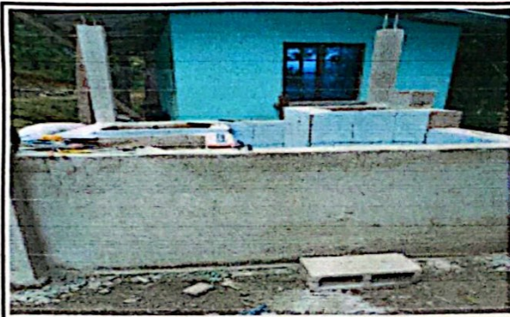
Foto 10: modulo 3 sustitucion de pila de concreto INSITU (2x2)
