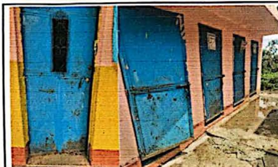
Foto 5: modulo 2 mantenimiento de puerta (lijado cepillado, sustitucion y aplicado de pintura)
