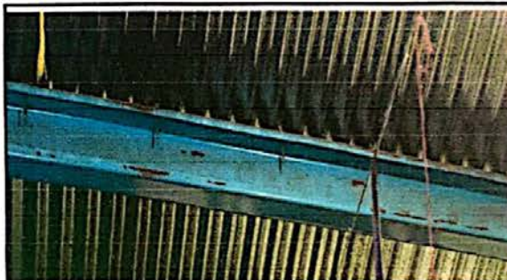
Foto 4: modulo 1 Sustitucion de elemento de fijación (tornillos)
