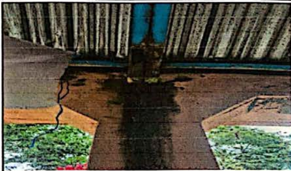
Foto 2: Modulo 1 mantenimiento de estructura de soporte
