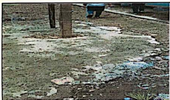
Foto 11. módulo 3 patio reparación de plancha de concreto de patio
