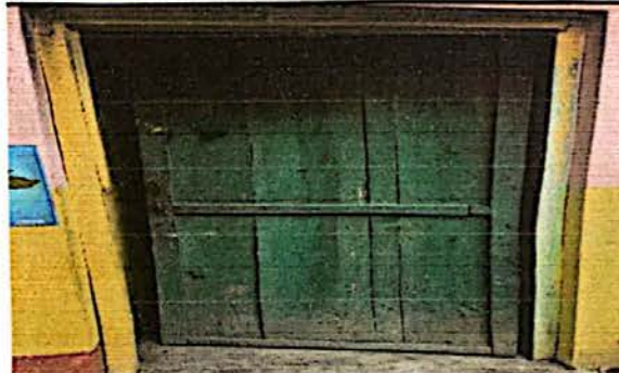
Foto 6 modulo 2 sustitucion de puerta de metal
