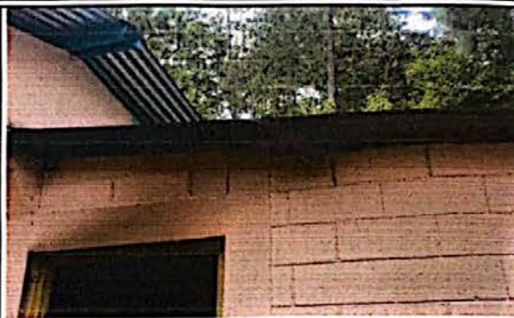
Foto 8: módulo 3 levantamiento de mojinetes
