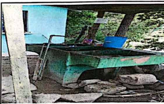
Foto 10: módulo 3 sustitución de pila de concreto INSITU (2x2)
