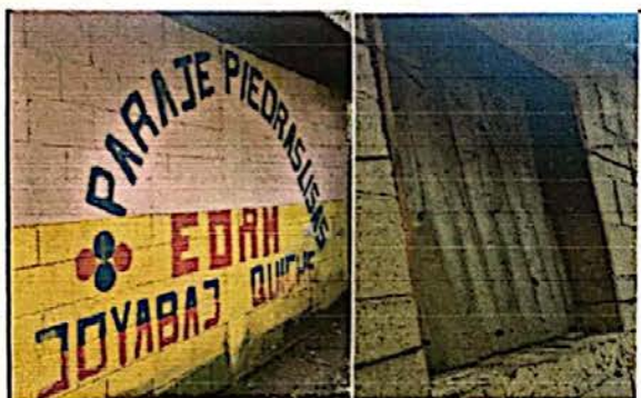
Foto 9: módulo 3 Levantamiento de ventanas
