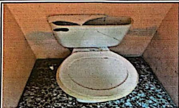
Foto 7: Módulo 2 sustitución de inodoros
