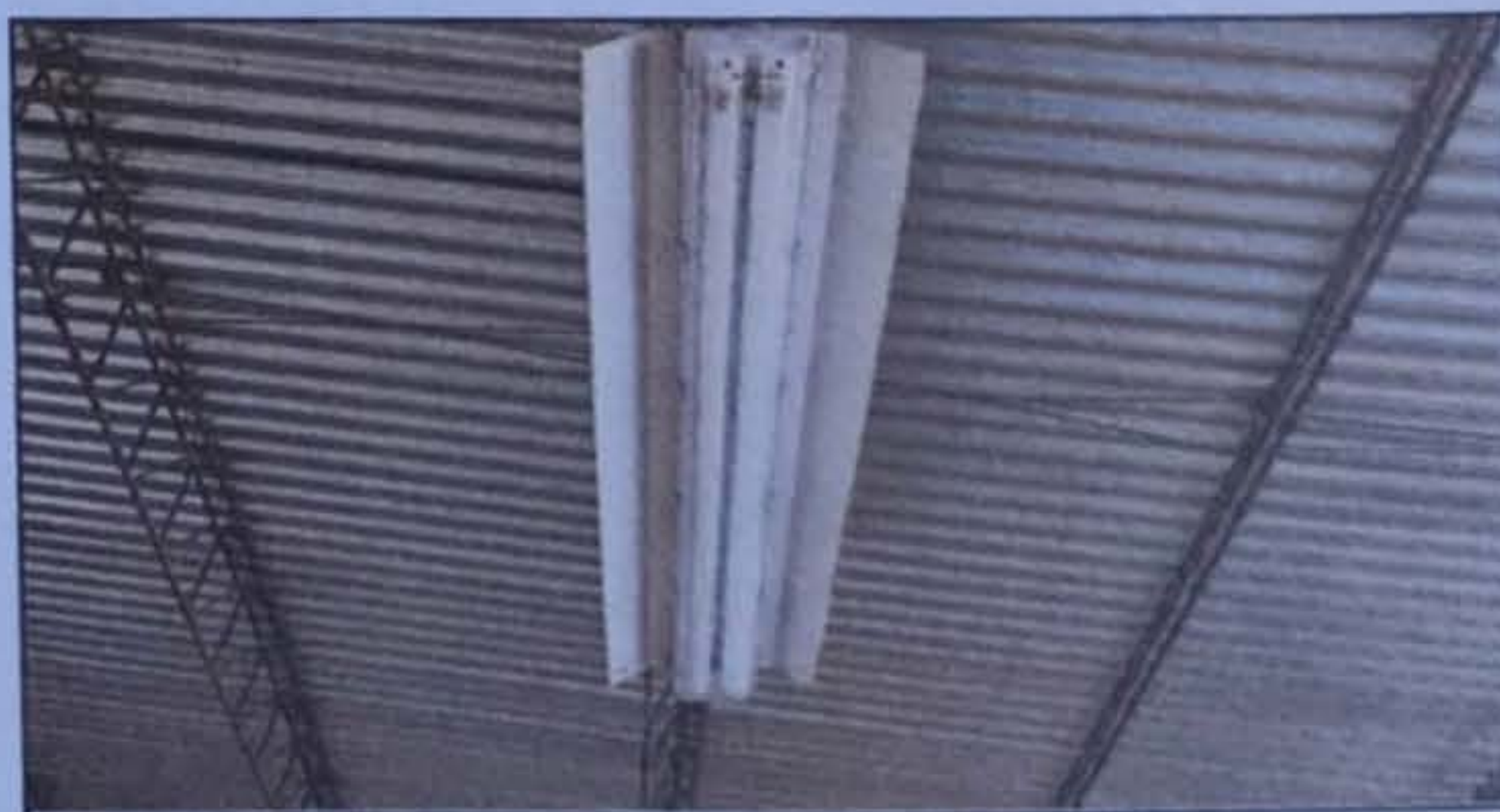
Foto 6: Modulo 1 Sustitucion de lampara tipo led.
