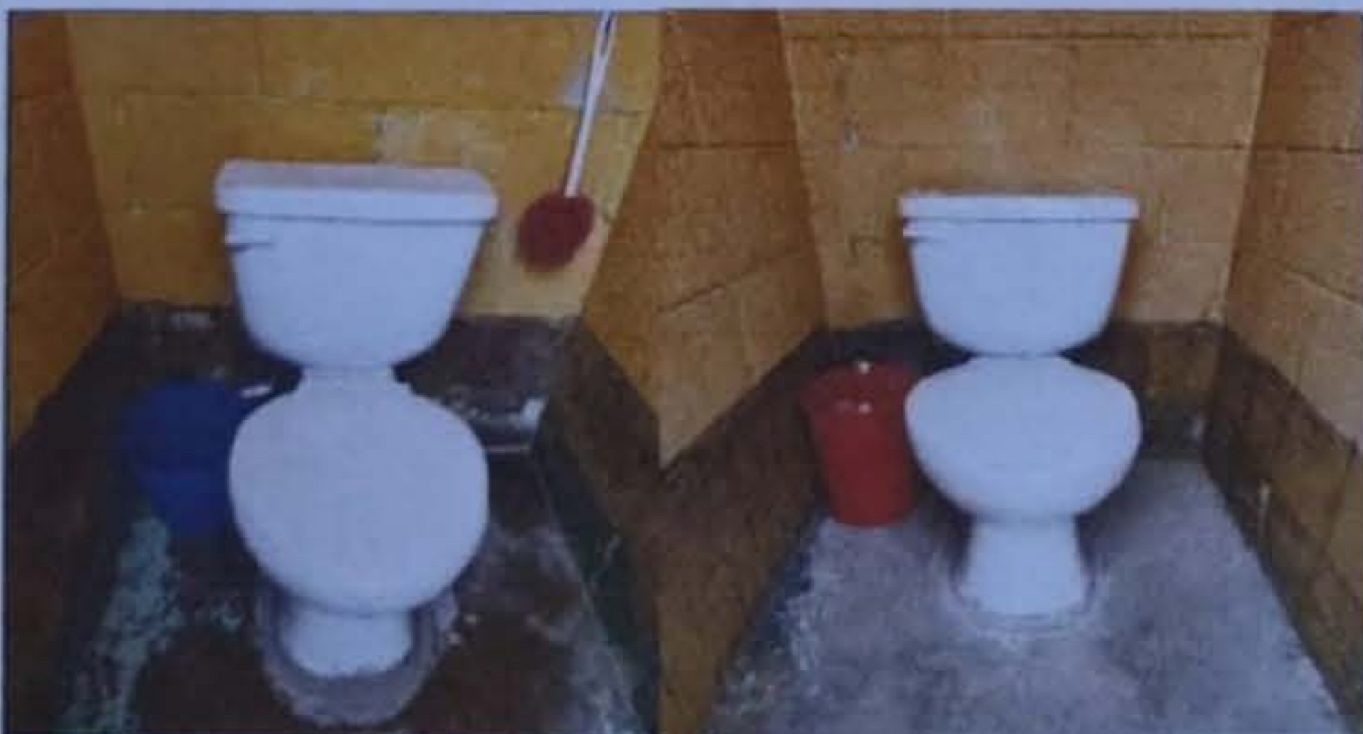
Foto 5: Modulo 2: Suministro e instalación de inodoro
