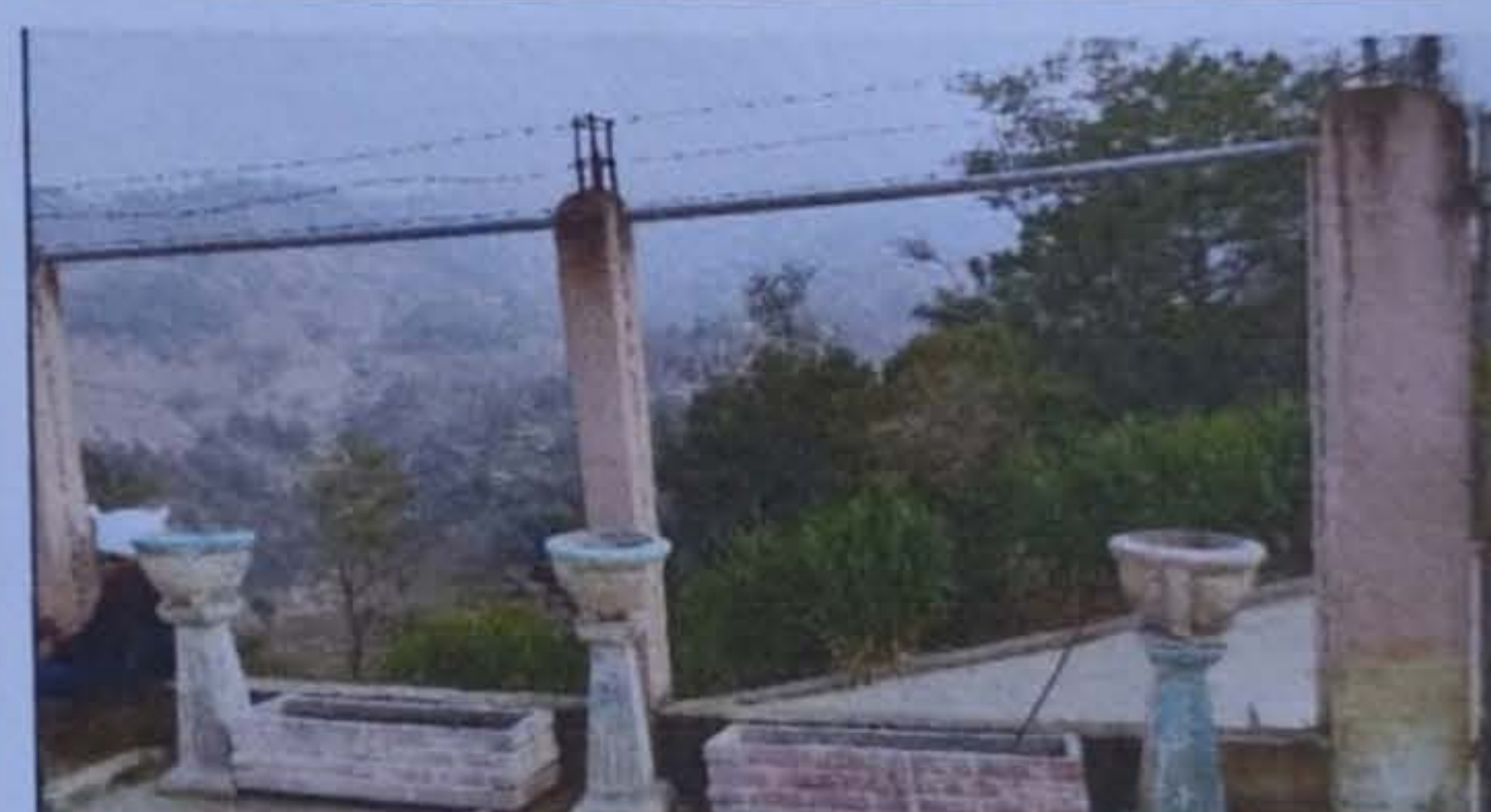
Foto 4: Muro perimetral: Repello en muro
