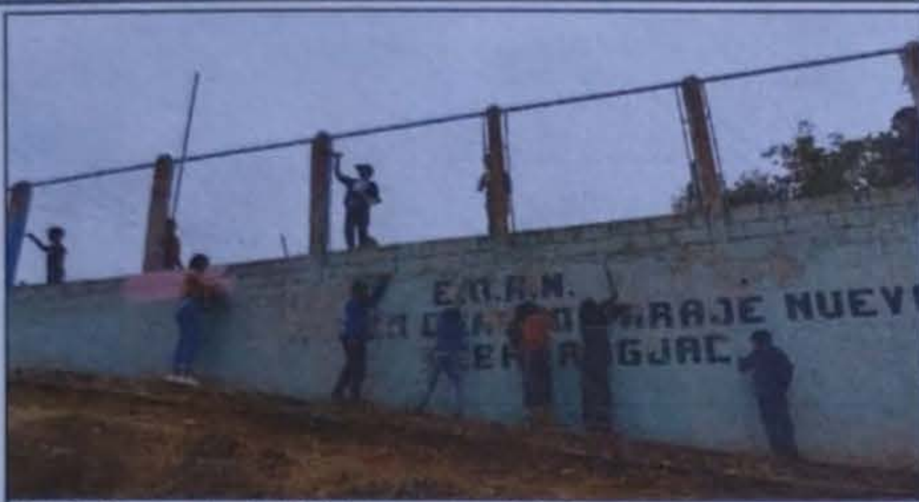
Foto7. Muro perimetral: Pintura en muro interior exterior
