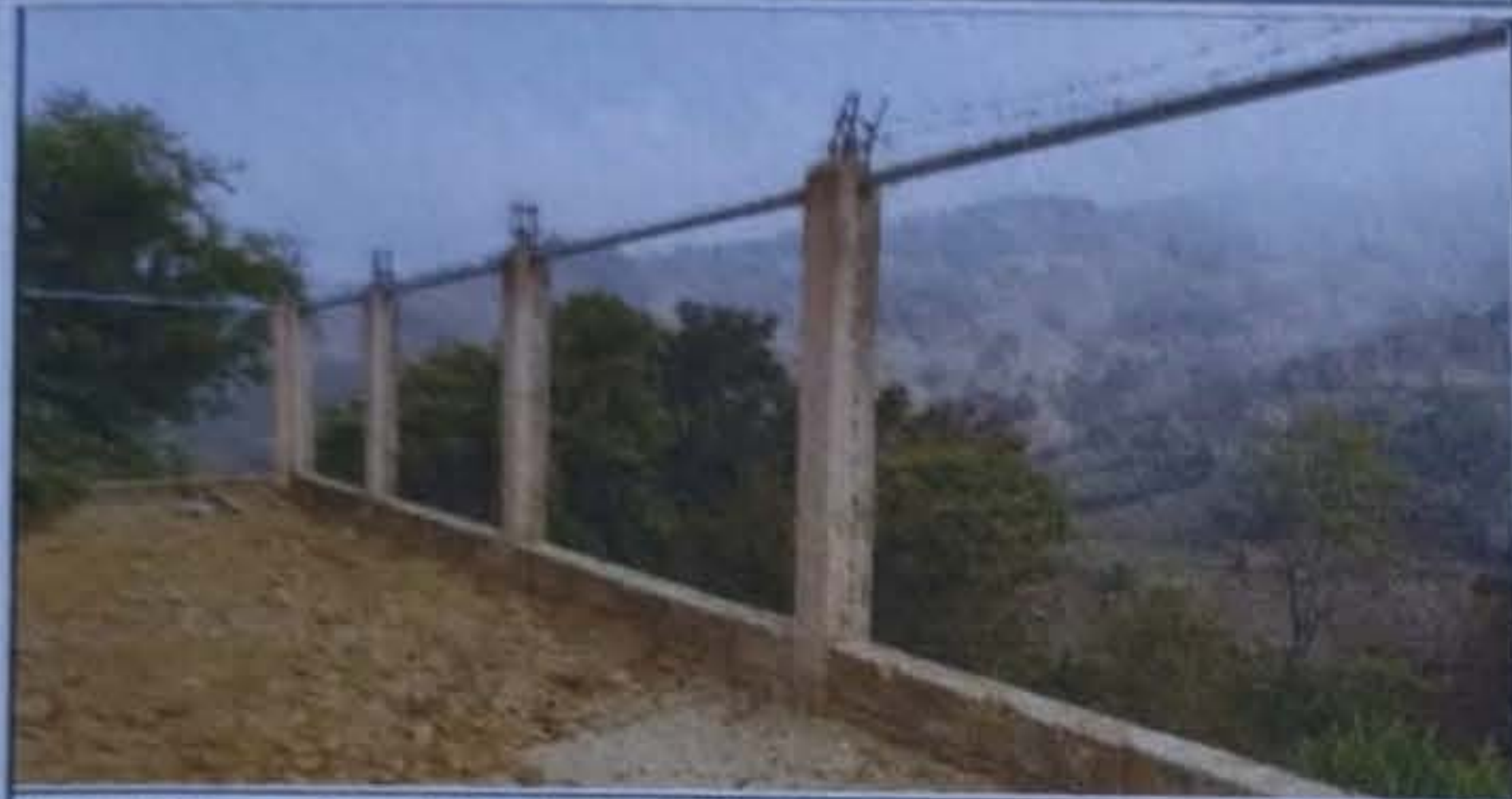
Foto 1: Muro perimetral : Reparación de muro perimetral, solera tubo hg leg.
