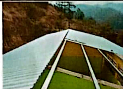
Foto 2: Sustrucción de capote de lamina para lamina troquelada
