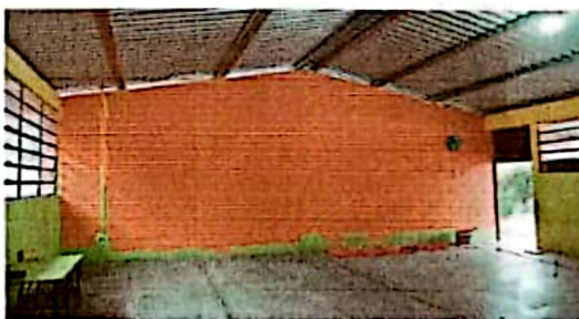
Foto 4: pintura de muro interiores
