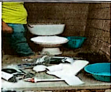
Foto 5: Reparación de baños
