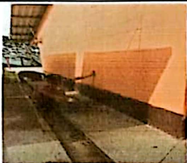
Foto 1: Pintura en muros exteriores
