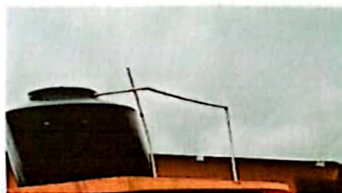
Foto 6: reparación de deposito de agua
