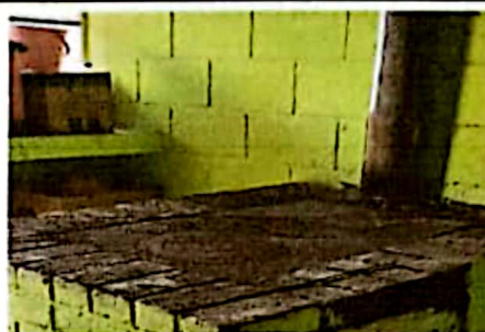
Foto 2: Sustitución de plancha de metal
