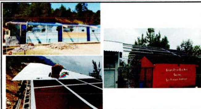
Foto1: En las imágenes vemos que el módulo I se le ha quitado completamente el capote y lámina de duralita, seguidamente se pintaron los soportes para posteriormente instalar la lámina aluzninc calibre 26.
