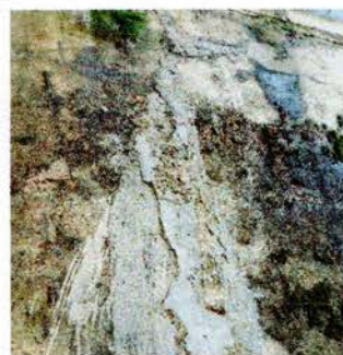
Foto 4: fundición de la grieta del muro de contención.
