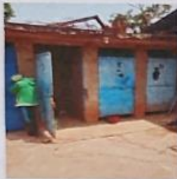
Módulo 3: Sustitución de puerta en servicios sanitarios
