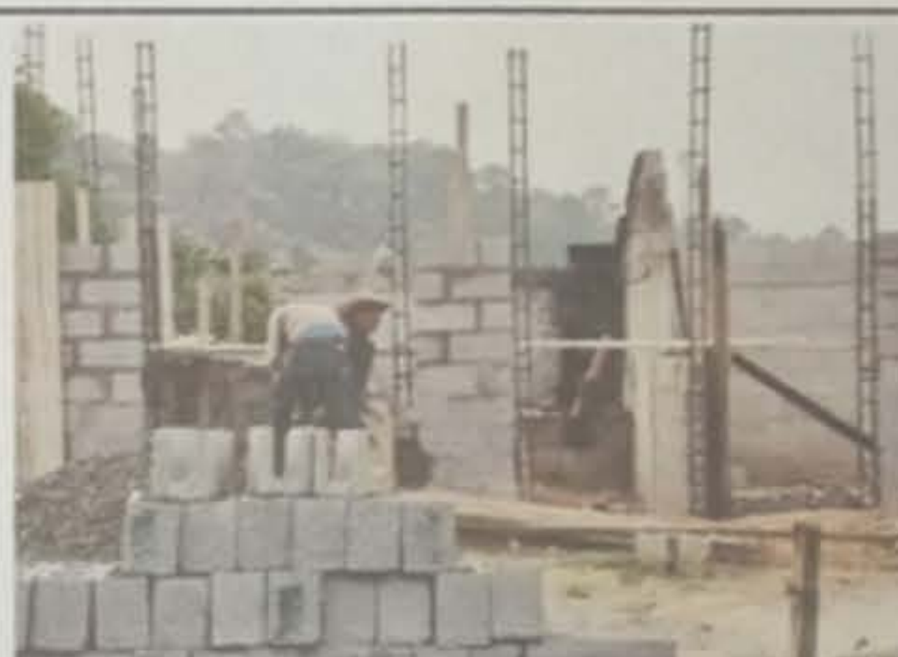
Módulo 4: Reparación de muro de cocina
