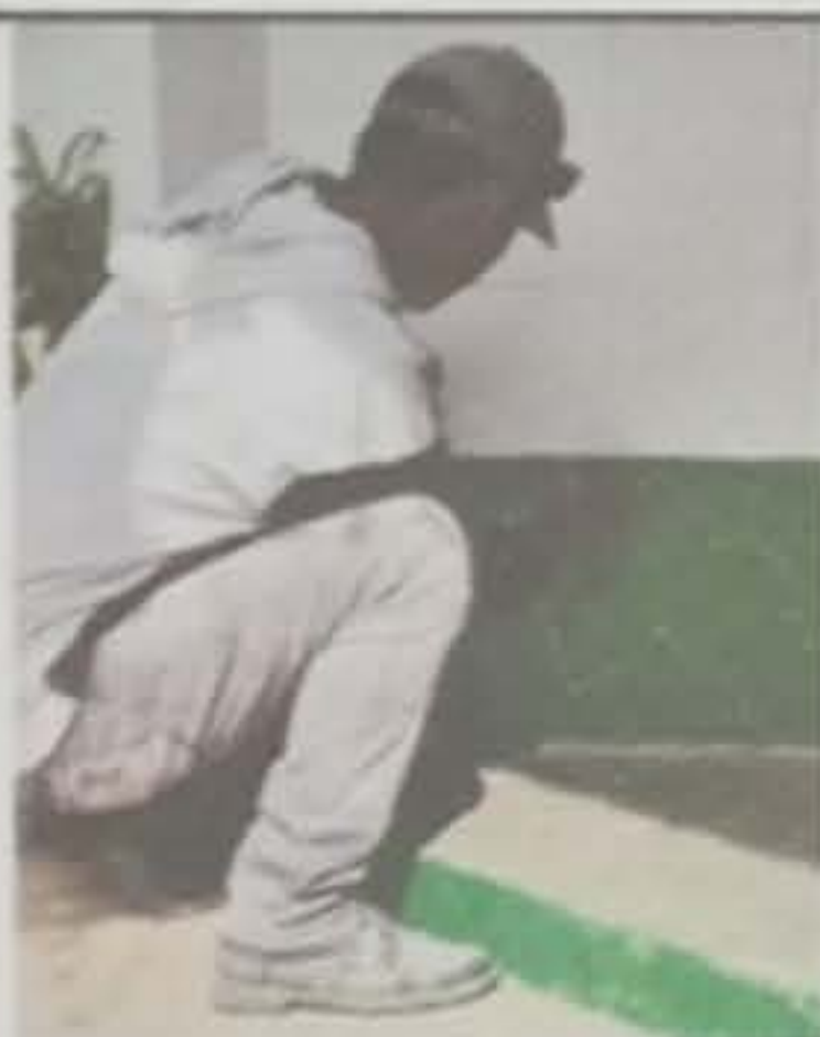
Módulo1:Pintura en muros exteriores e interiores
