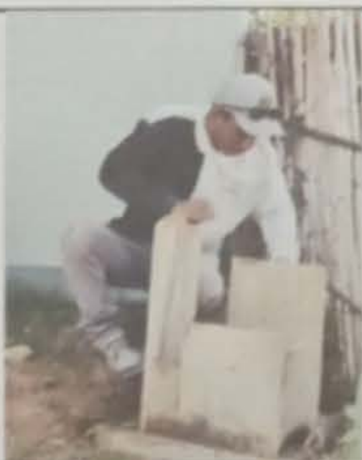
Sustitución de caja de registro
