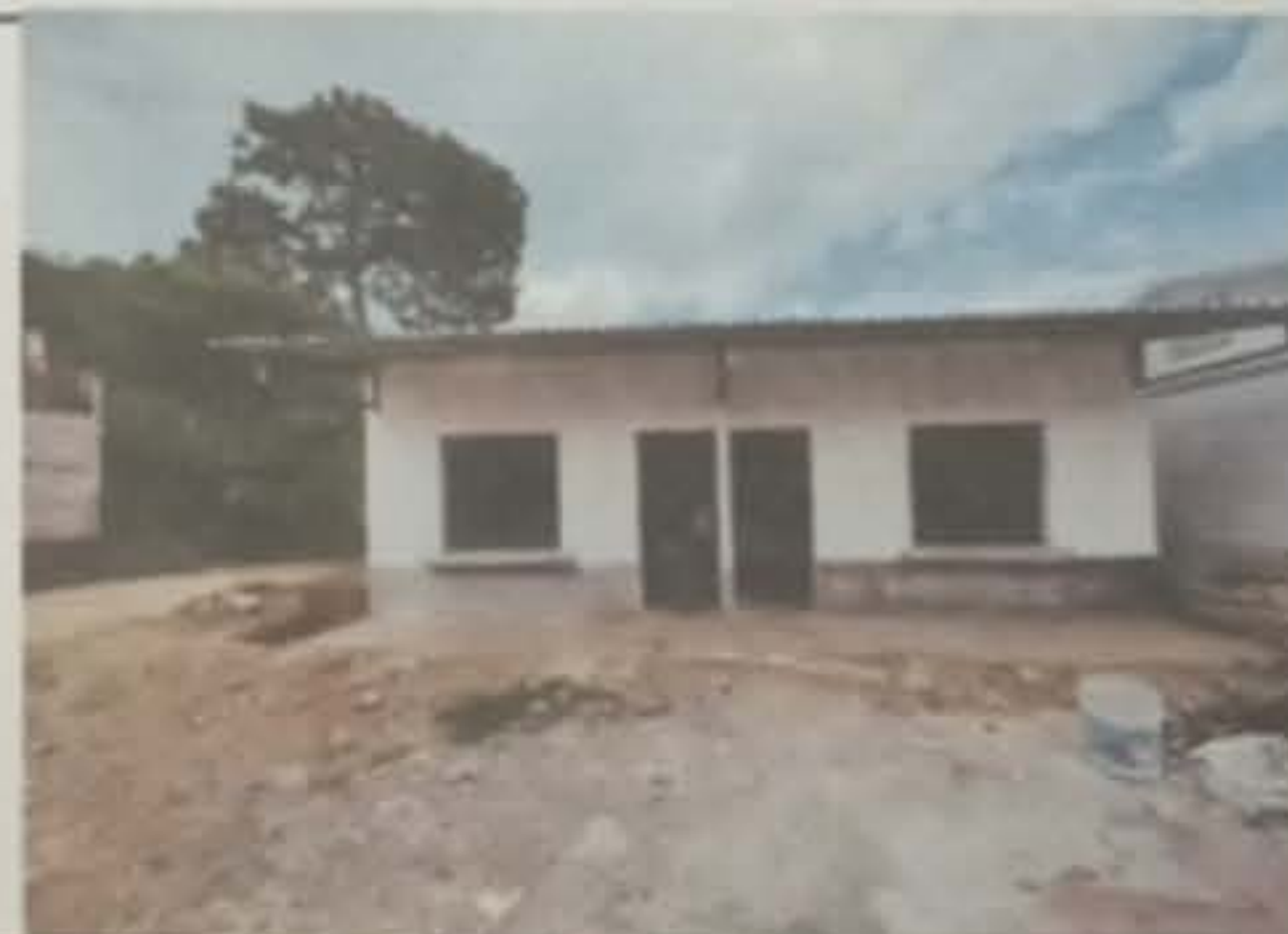
Módulo 4: Sustitución de lámina, por lámina troquelada aluzinc calibre 26
