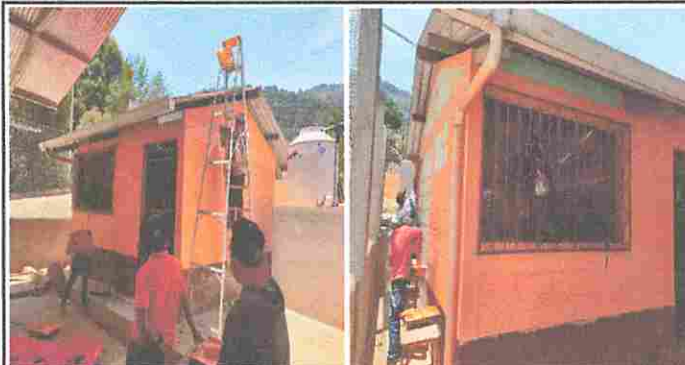
Foto 8: Módulo 3: Pintura de paredes interiores y exteriores.
