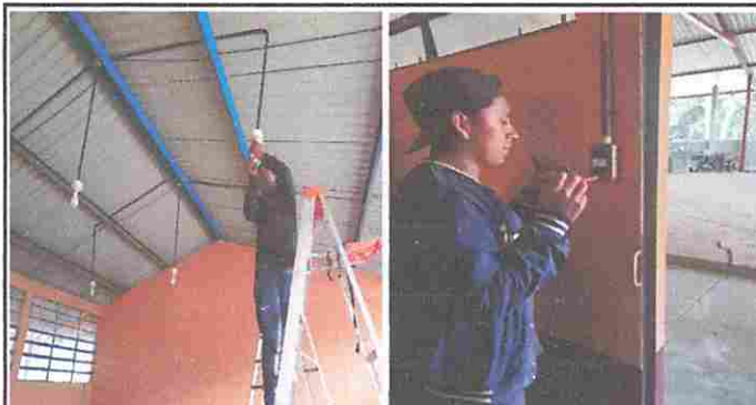
Foto 4: Módulo 1: Sustitución de focos ahorradores y Sustitución de interruptores simples.
