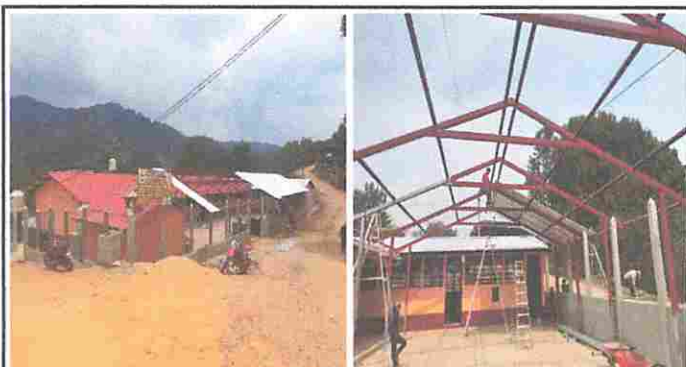
Foto 11: Módulo 4: Sustitución de lámina por lámina troquelada, Sustitución de capote y Sustitución de elementos de fijación (tornillos).
