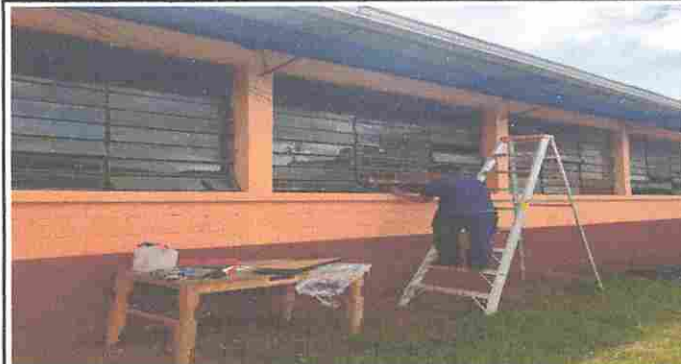
Foto 2: Módulo 1: Sustitución de vidrios.
