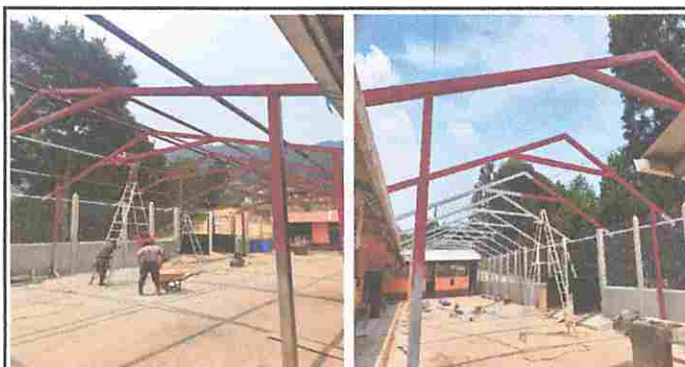
Foto 12: Módulo 4: Sustitución de estructura de soporte de metal por metal.
