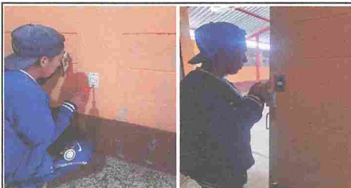
Foto 10: Módulo 3: Sustitución de interruptores simples y Sustitución de tomacorrientes dobles.
