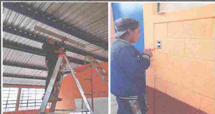
Foto 7: Módulo 2: Sustitución de focos ahorradores, Sustitución de plafoneras y Sustitución de interruptores simples.
