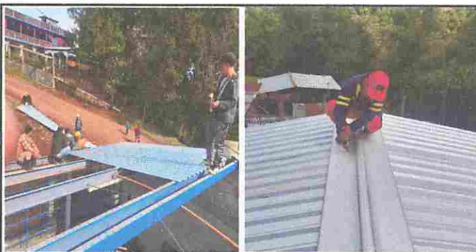
Foto 5: Módulo 2: Sustitución de lámina por lámina troquelada, Sustitución de capote y Sustitución de elementos de fijación (tornillos).
