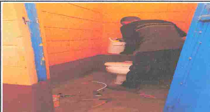
Foto 3: Módulo 1: Sustitución de Inodoro.
