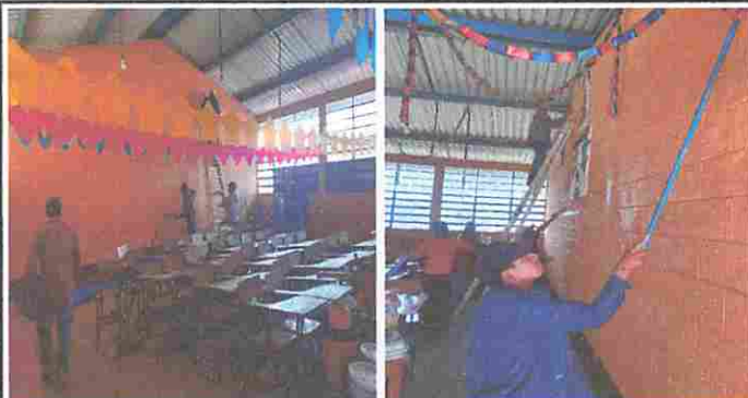
Foto 1: Módulo 1: Pintura de paredes interiores y exteriores.
