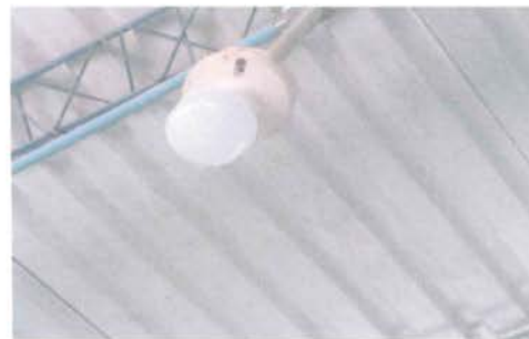
Modulo 1. Sustitucion de focos ahorradores
