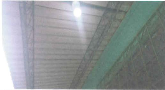
Módulo 2: Sustitución de plafoneras
