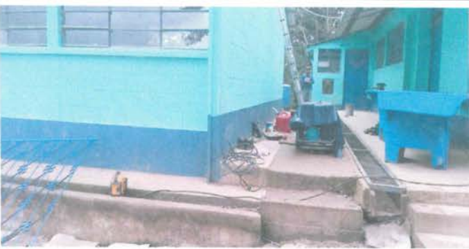
Módulo 3: Sustitución de balcones de metal
