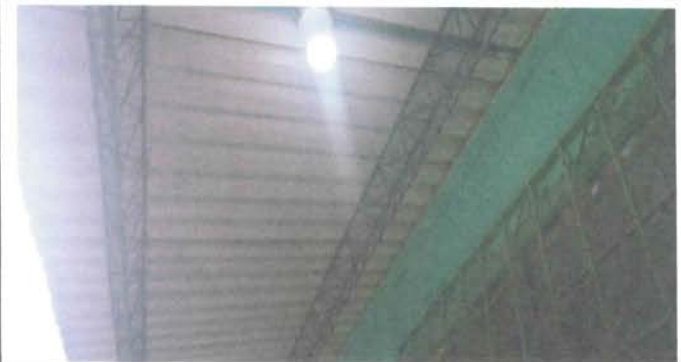
Módulo 4: Sustitución de plafoneras
