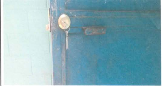
Módulo 2: Sustitución de chapas
