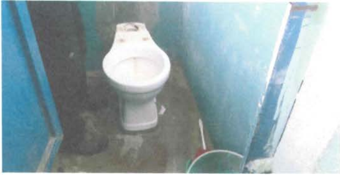
Módulo 4: Sustitución de inodoro
