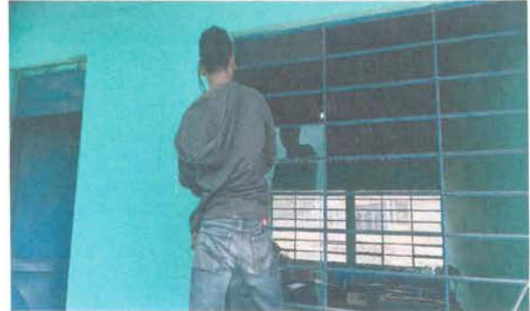
Modulo 1. Sustitucion de vidrios.
