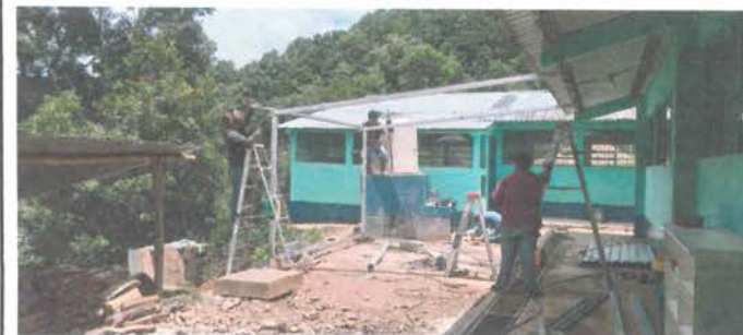
Módulo 5: Sustitución de lámina
