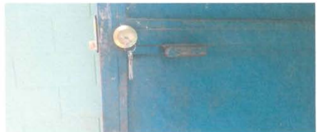
Modulo 2. Sustitucion de chapas
