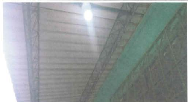
Módulo 3: Sustitución de plafoneras
