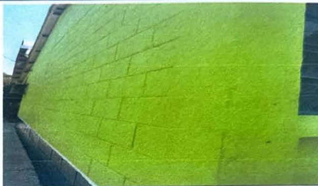
Modulo 1: Pintura en muros exteriores e interiores
