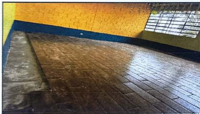
Modulo 1: Sustitución de piso cerámico
