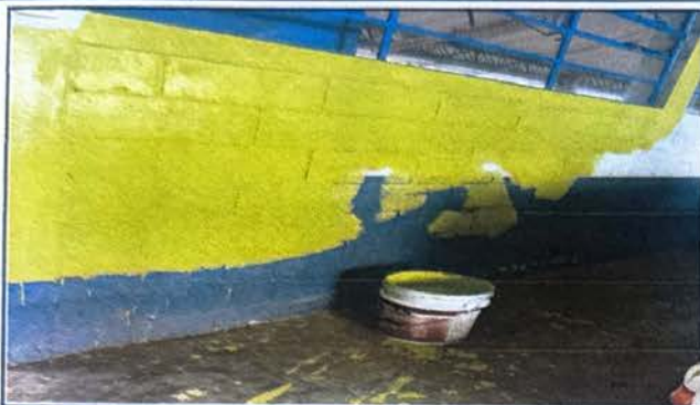
Modulo 1: Pintura en muros exteriores e interiores
