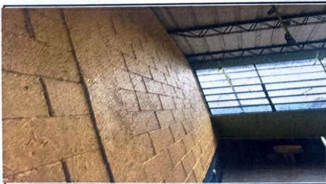
Modulo 2: Pintura en muros exteriores e interiores
