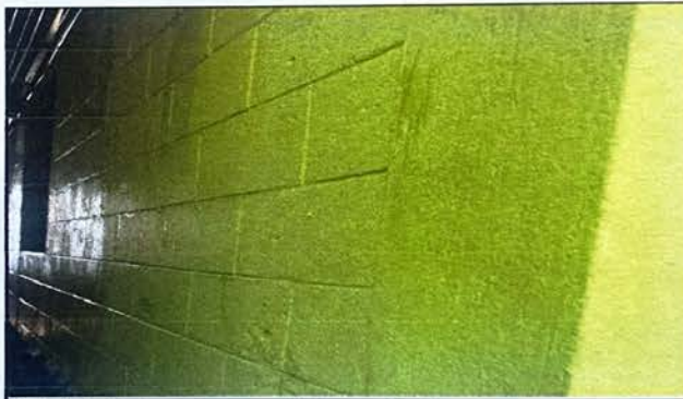
Modulo 2: Pintura en muros exteriores e interiores
