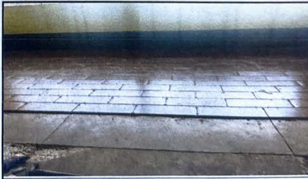
Modulo 2: Sustitución de piso cerámico
