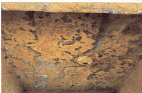
Foto 5: LA ACUMULACION DE HUMEDAD EN LOSA DE SANITARIOS POR FALTA DE PAÑUELOS.
