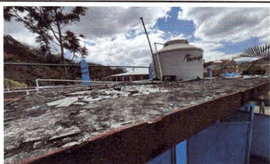
Foto 4: PAÑUELOS INEXISTENTES EN LOSA DONDE SE UBICA DEPOSITO DE AGUA
