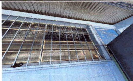
Foto 2: VIDRIOS QUEBRADOS EN PARTE POSTERIOR DE LAS AULAS
