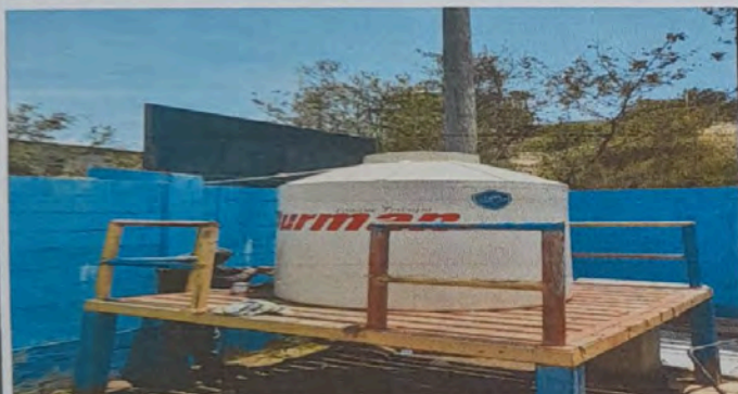
Foto 9: MODULO 18. SUSTITUCIÓN DE DEPOSITO DE AGUA 1700 LITROS
