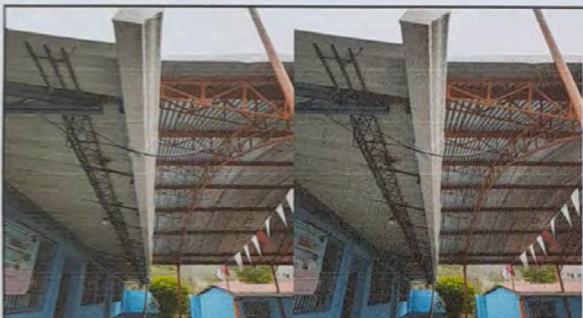
Foto 3: MUDULO 7. SUSTITUCIÓN DE CANALES DE METAL POR CANALES PVC
