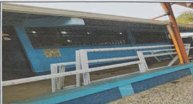
Foto1: MODULO 5. SUSTITUCIÓN DE ESTRUCTURA METALICA DE VENTANA POR VENTANA DE PVC
