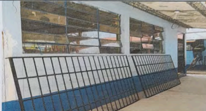
Foto 2: MODULO 5. COLOCACION DE BALCONES DE METAL
