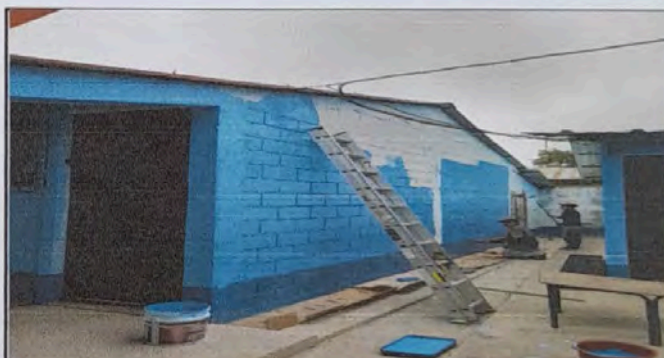
Foto 4: MODULO 9. PINTURAS PARA AULAS Y MURO
