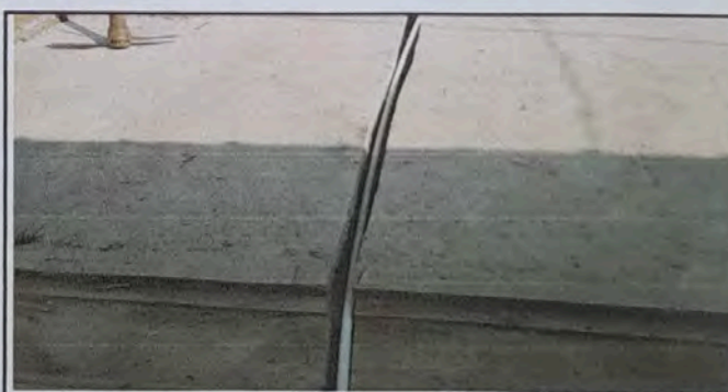
Foto 6: MODULO 15. SUSTITUCIÓN DE TUBERÍA DE LINEA PRINCIPAL
