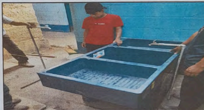
Foto 10: MODULO 19. INSTALACIÓN DE PILA DE PLASTICA DE 2 LAVADERAS
