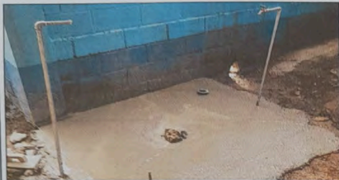
Foto 7: MODULO 15. SUSTITUCIÓN DE LLAVES DE CHORROS
