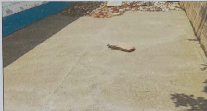
Foto 8: MODULO 16. REPARACIÓN DE PLANCHA DE CONCRETO DE PATIO
