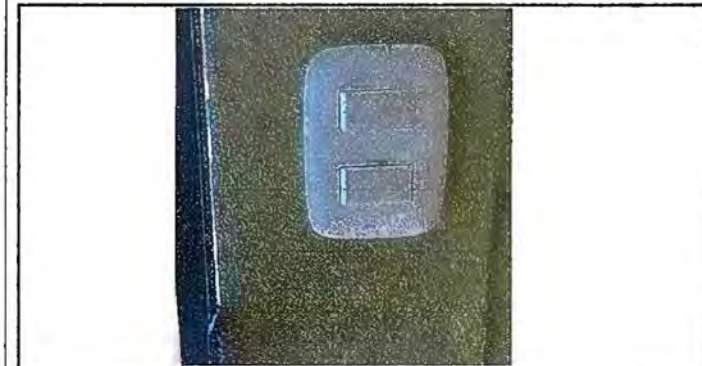
Foto 10. Módulo 2: Sustitucion de interruptores dobles.
