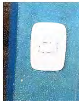
Foto 4. Módulo 3: Sustitución de interruptores simples.
