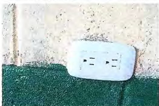
Foto 9. Módulo 1: Sustitución de tomarrientes dobles.
