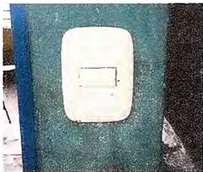
Foto 7 Módulo 1: Sustitucion de interruptores simples.
