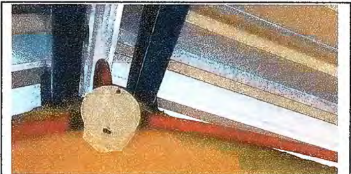
Foto 6 Modulo1: Sustitución de ducto eléctrico + accesorio
