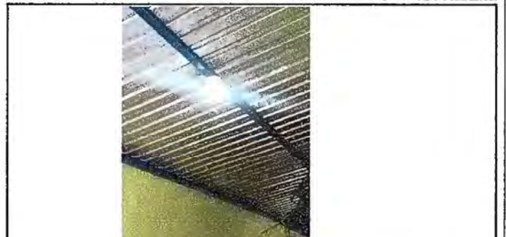
Foto13. Módulo 2: Sustitución de focos ahorradores.
