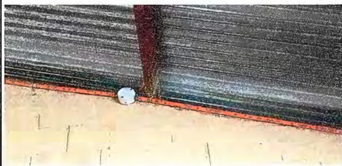
Foto 3. Módulo 3: Sustitución de ducto eléctrico mas accesorio.
