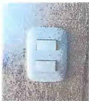
Foto 5. Módulo 3: Sustitución de interruptores dobles.
