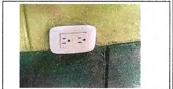
Foto 11. Módulo 2: Sustitución de tomarrientes dobles.
