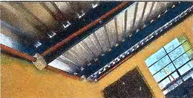
Foto 5 Módulo 1: Reparacion de cableado eléctrico.
