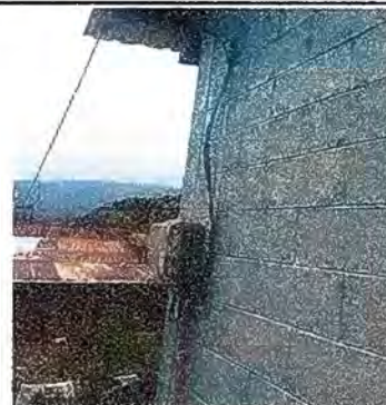
Foto 12. Módulo 1: Instalación de acometida eléctrica.
