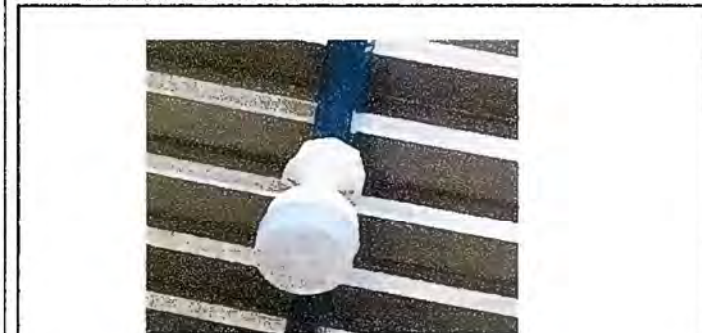
Foto 12. Módulo 2: Sustitución de plafoneras.
