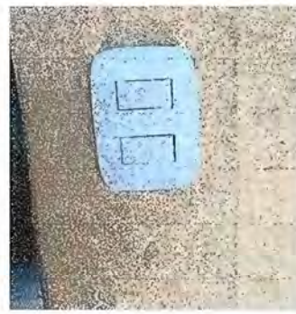
Foto 8 Módulo 1: Sustitucion de interruptores dobles.
