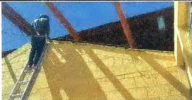
Foto 5 Módulo 1: Reparacion de cableado eléctrico.
