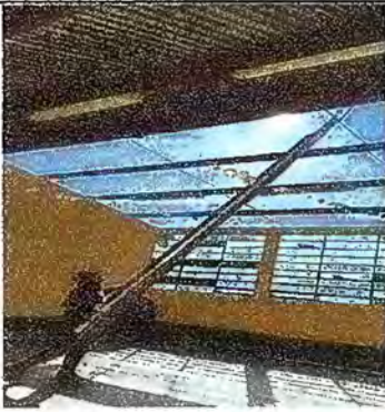
Foto 1. Módulo 1: Sustrucion de lámimina, por lámina troquelada aluzinc calibre 26.
