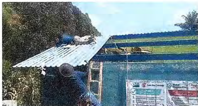
Foto 2. Módulo 2: Sustitucion de elemento de fijacion de (tornillos).
