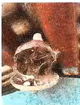
Foto 12. Módulo 2: Sustitución de plafoneras.
