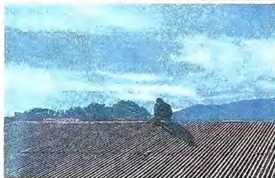
Foto 3. Módulo 2: Sustitucion de capote de lamina para lámina troquelada
