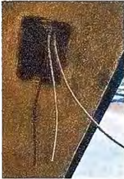
Foto 7 Módulo 1: Sustitución de interruptores simples.
