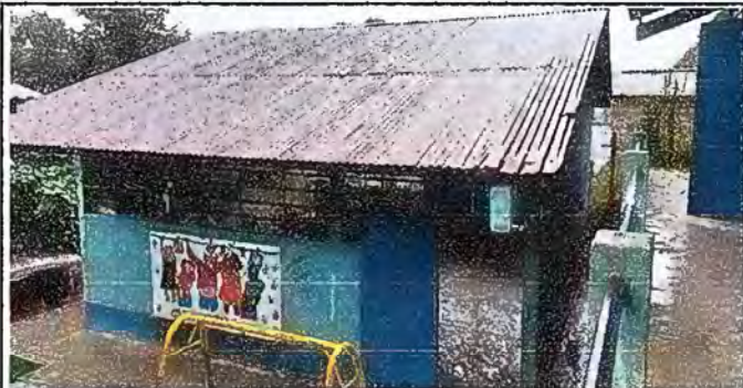
Foto 1. Módulo 1: Sustitución de lámina, por lámina troquelada aluzinc calibre 26.
