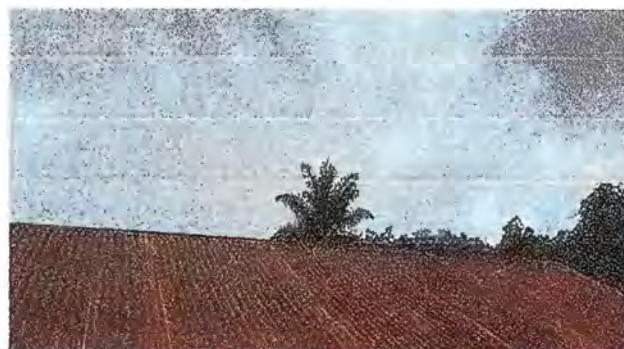
Foto 3. Módulo 2: Sustitucion de capote de lamina para lámina troquelada
