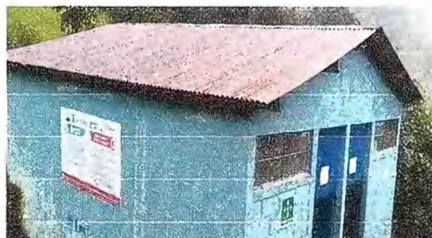
Foto1. Módulo 2: Sustitución de lámina, por lamina troquelada aluzinc calibre 26.
