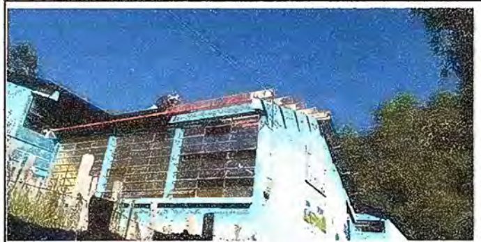
Foto 2. Módulo 1: Sustitución de elemento de fijación de (tornillos).
