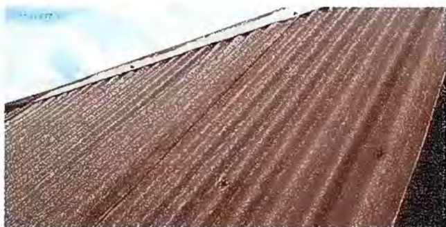
Foto 3. Módulo 1: Sustitución de capote de lámina por lámina troquelada
