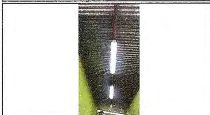
Foto 12. Módulo 2: Sustitución de plafoneras.
