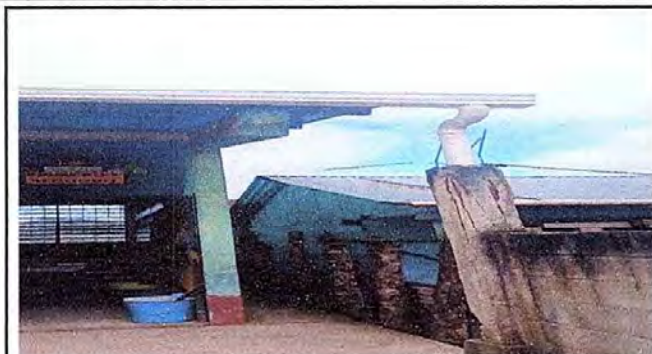
foto 7. MÓDULO 2: Sustrucción de bajada de agua pluvial de PVC por tubo PVC 3".
