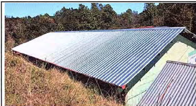
fotoграфия 1 MÓDULO 1: Sustitución de láminas por lámina troquelada aluzinc calibre 26
