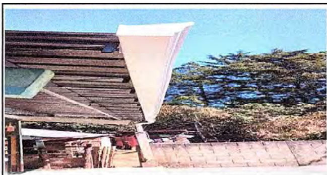
fotoграфия 5 MÓDULO 2: Sustitución de canal PVC.
