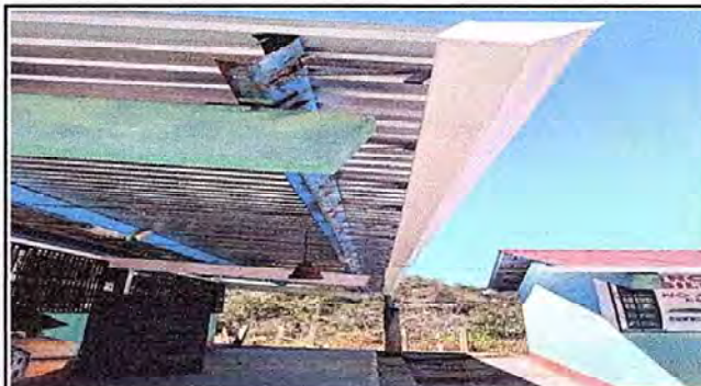
fotoграфия 2 MÓDULO 1: Sustitución de canal PVC
