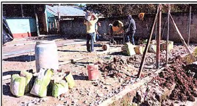
foto 8. PATIO: Reparación de plancha de concreto de patio.
