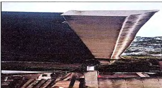
fotografía 6. MÓDULO 2: Sustitucion de soporte o pescante de metal para canal.
