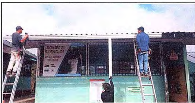
fotografía 5. MÓDULO 2: Sustitución de canal PVC.
