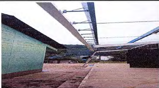
fotografía 3. MÓDULO 1: Sustitución de soporte o pescante de metal para canal
