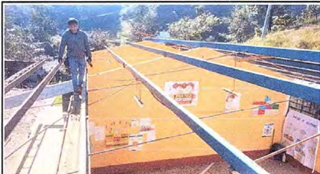
fotografía 1. MÓDULO 1: Sustitucion de laminas, por lamina troquelada aluzinc calibre 26
