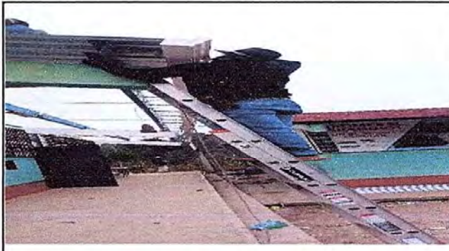
fotografía 2. MÓDULO 1: Sustitución de canal PVC
