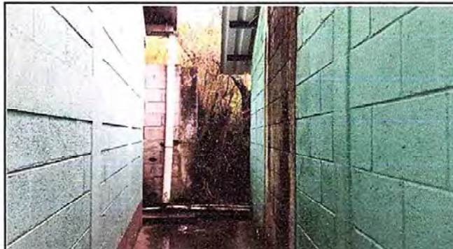
fotografia 4 MODULO 1: Sustitución de bajada de agua pluvial de PVC por tubo PVC "3"
