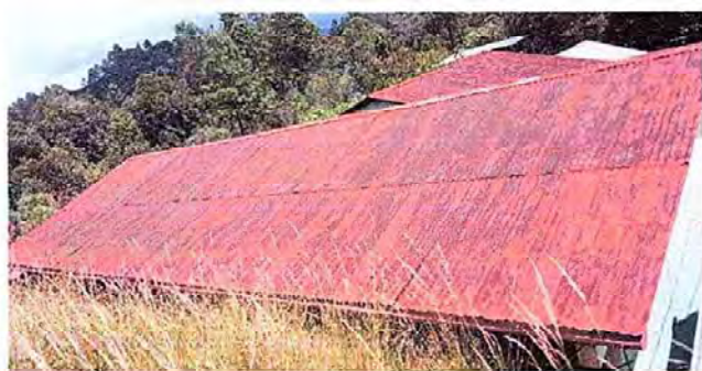
fotografia 1 MÓDULO 1: Sustitución de lamina, por lamina troquelada aluzinc calibre 26
