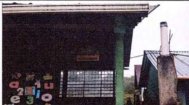
Foto 7. MODULO 2: sustitución de bajada de agua pluvial de PVC por tubo PVC 3"
