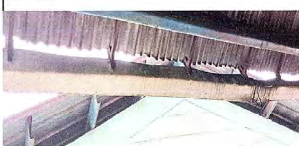
fotografia 2 MÓDULO 1: Sustitución de canal PVC
