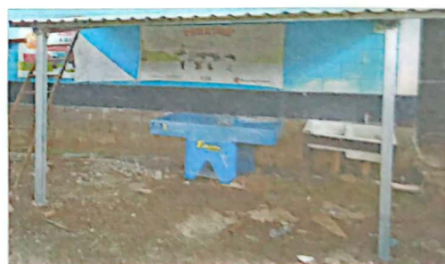
Foto 6: Sustrucción de tubos y colocación de chorros para lavamanos. Y se sustituye lavamanos de plástico por una pila de cemento.
