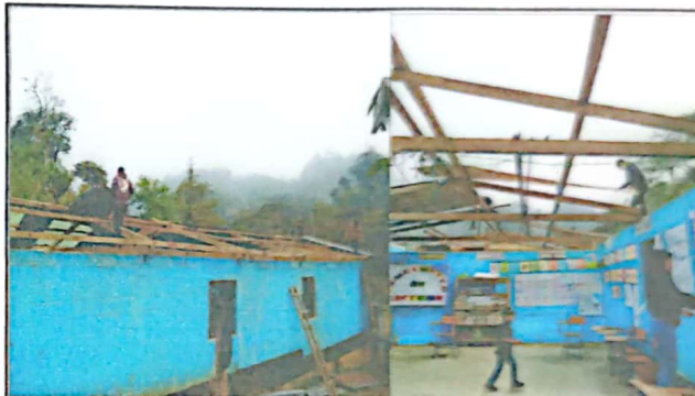
Foto 4: Sustrucción de techos de 46 láminas para 2 aulas.
