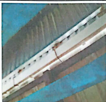
Foto 5: Sustrucción de 9 canales de plástico..
