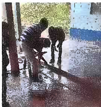
Foto 5: Sustitución de piso de torta a piso cerámica
