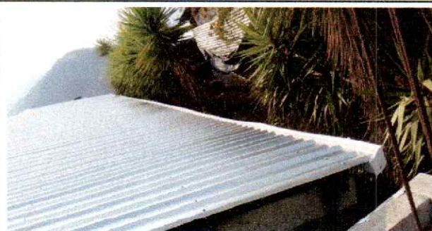
Foto 3: Se ha iniciado con la instalación de cubierta de lámina troquelada calibre 26 en módulo de aulas.
