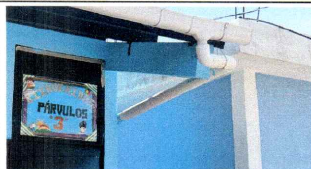
Foto 5: Se ha iniciado con la instalación de canal pluvial + bajada de agua.
