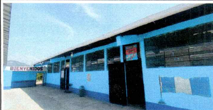
Foto 2: Puede verificarse el remozamiento en la cubierta del módulo de aulas, cambio de estructura portante de metal e instalación de cubierta de lámina troquelada calibre 26
