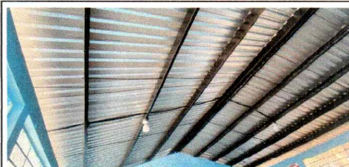
Foto 4: Se verifica el remozamiento de estructura portante de metal y cubierta de lámina troquelada calibre 26 dentro de aula 1.
