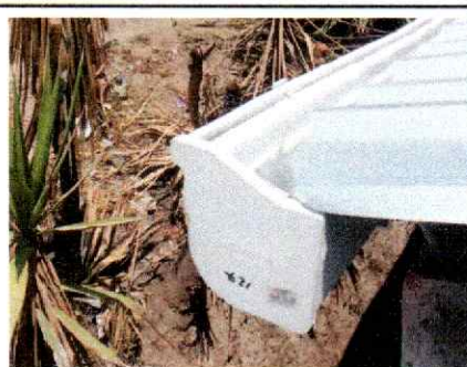
Foto 6: Se ha iniciado con la instalación de canal pluvial.
