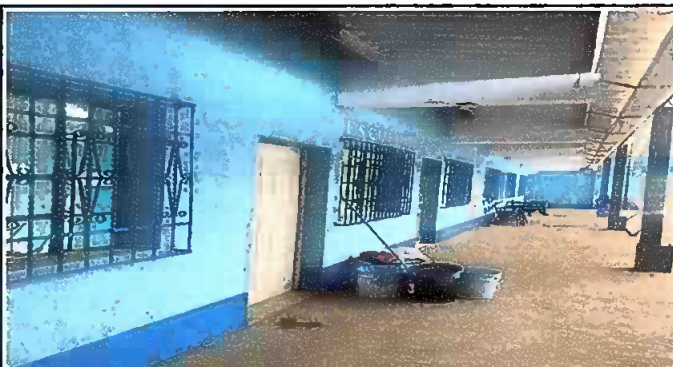
Foto 4: MÓDULO 3. Suministro e instalacion de balcones
