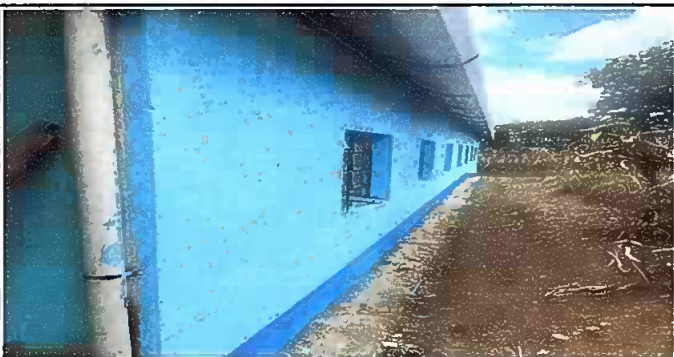
Foto 5: MÓDULO 3. Pintura en muros interiores y exteriores.
