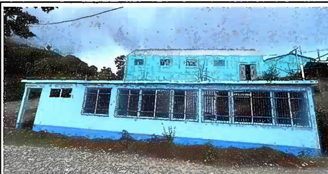
Foto 6: MÓDULO 3. Pintura en muros interiores y exteriores.
