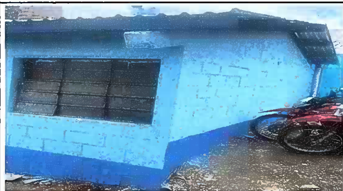
Foto1: MODULO 1. Cocina culminada, techo y pintura en interior y exterior
