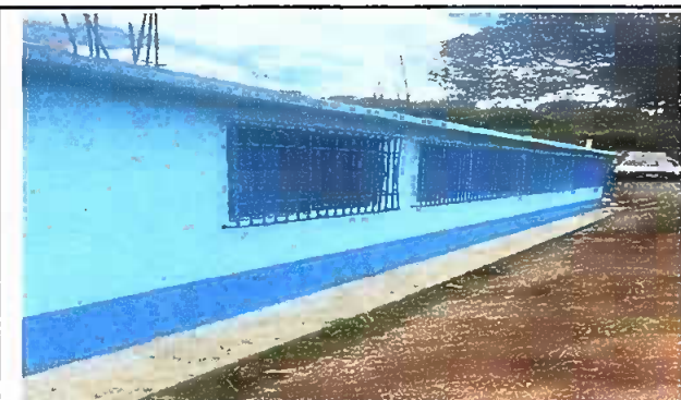
Foto 3: MÓDULO 2. Suministro e instalacion de balcones
