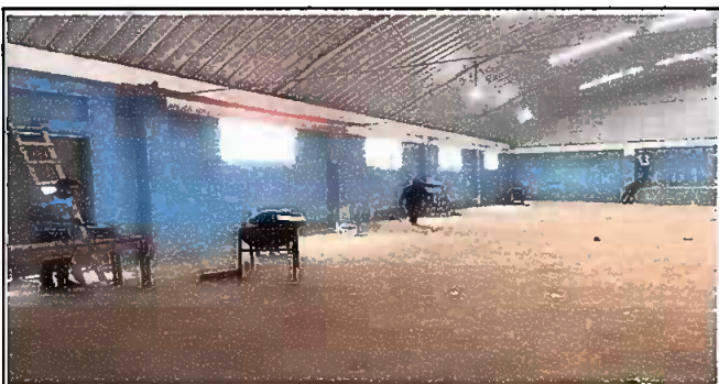
Foto 5: MÓDULO 3. Pintura en muros interiores y exteriores.
