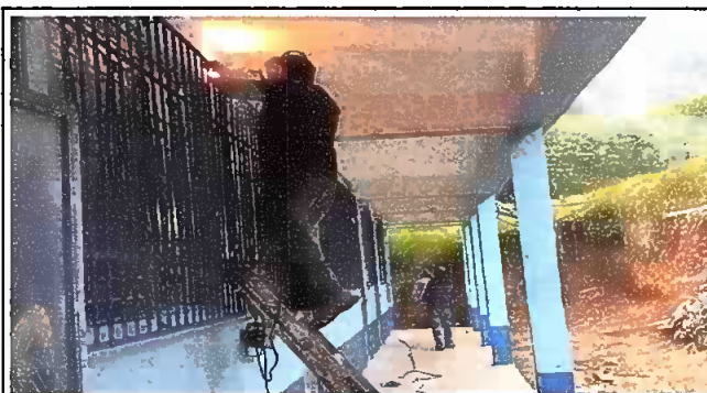
Foto 4: MÓDULO 3. Suministro e instalacion de balcones
