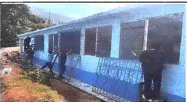
Foto 3: MÓDULO 2. Suministro e instalacion de balcones
