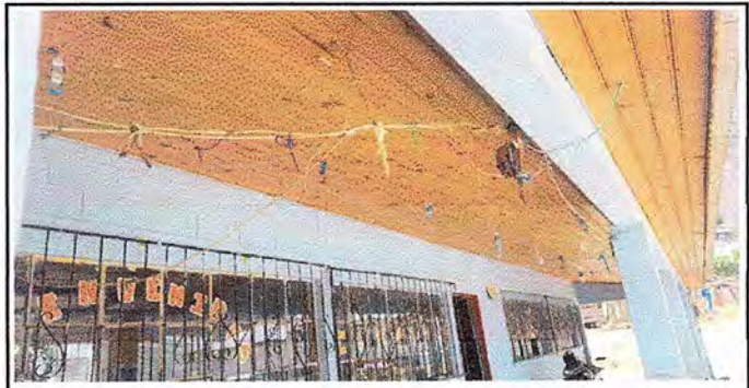
Foto 6: MODULO 3 Reparación de sistema eléctrico.
