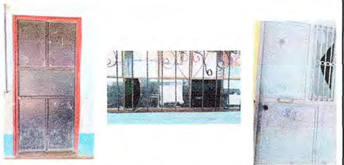
Foto 4: MODULO 1 sustitución de chapas, puerta y vidrios.
