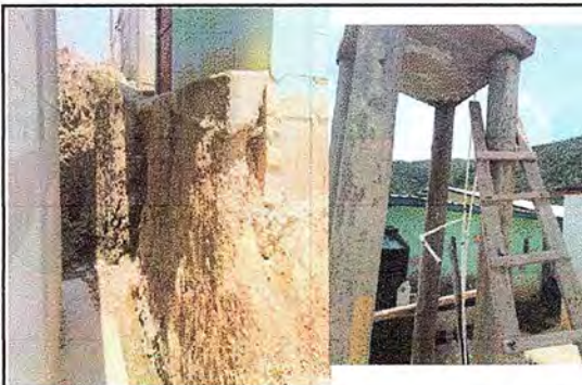
Foto 5: Reparacion de muro de contension de block, mas cemento columnas y soleras
