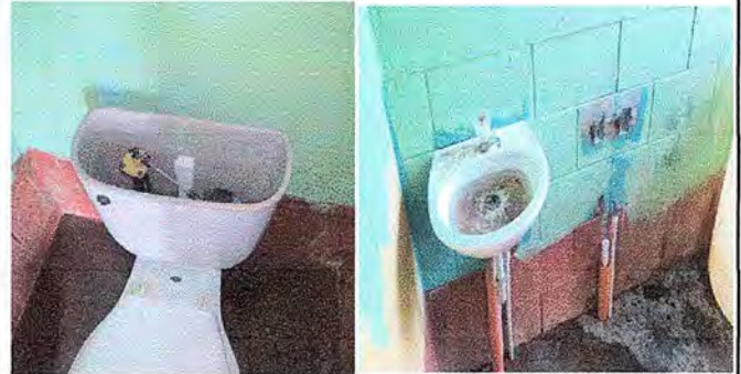
Foto 2: SERVICIO SANITARIOS Sustitucion de inodoros y lava manos
