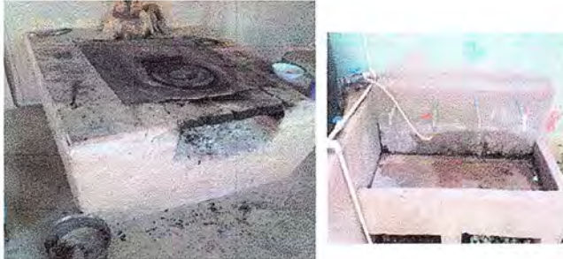
Foto1: COCINA Sustitución de estufa rural (completa) incluye chimenea y plancha de metal sistema eléctrico, llave de chorro. Reparación de ducto eléctrico.
