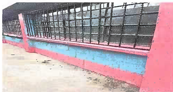
Modulo 2 Foto 1: Suministro e instalación de balcones
