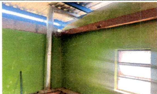
Foto 3: Se observa el remozamiento en estufa rural, ya cuenta con cambio de chimenea en estufa rural.
