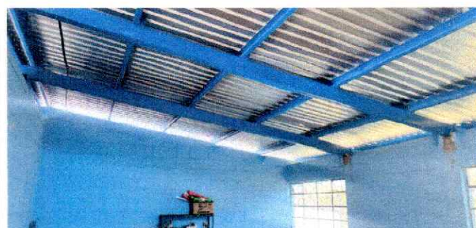
Foto 10: Se ha concluido con la instalación de lámina troquelada calibre 26 en aula 2.
