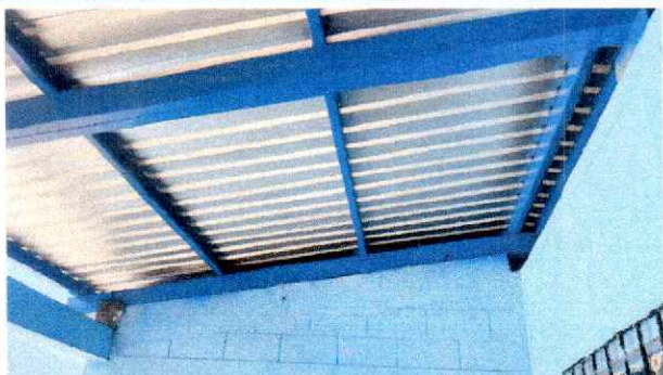
Foto 7: Se ha concluido con la instalación de estructura portante de metal e instalación de cubierta de lámina troquelada calibre 26 en corredor.
