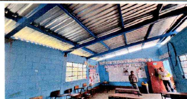
Foto 11: Se ha concluido con la instalación de estructura portante de metal e instalación de cubierta de lámina troquelada calibre 26 en aula 2.
