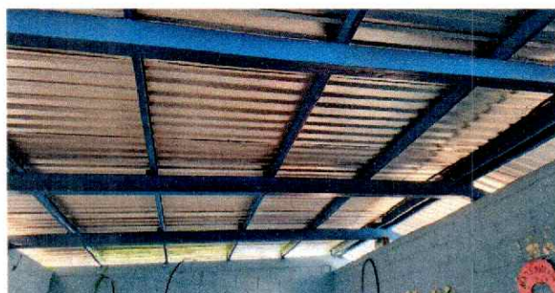
Foto 9: Se ha concluido con la instalación de estructura portante de metal en aula 2.
