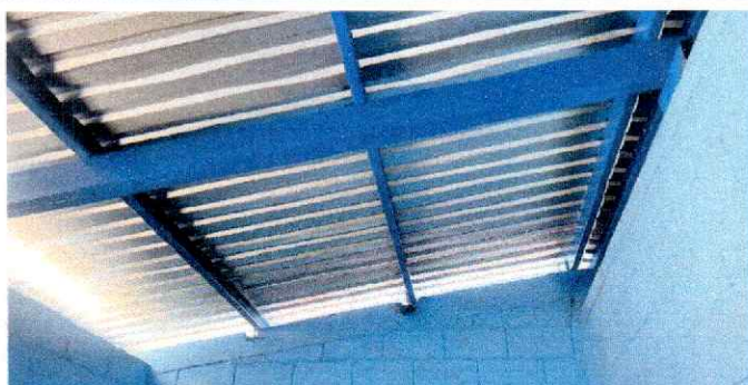
Foto 8: Se ha concluido con la instalación de estructura portante de metal e instalación de cubierta de lámina troquelada calibre 26 en dirección.
