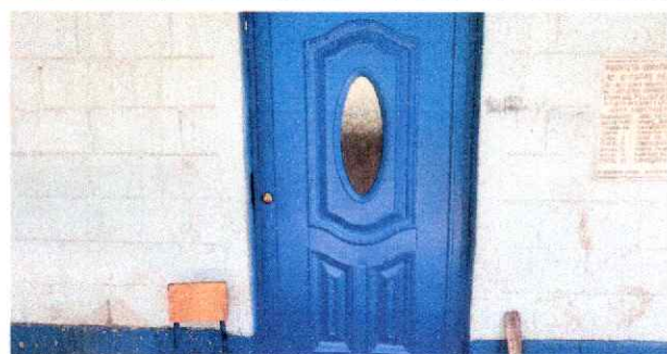
Foto 9: Se puede verificar la instalación de una puerta de metal en el área de cocina del establecimiento
