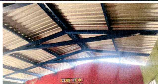
Foto 3: Se verificaron las conexiones de la estructura portante de metal, denotándose soldaduras con cordones prolijos.
