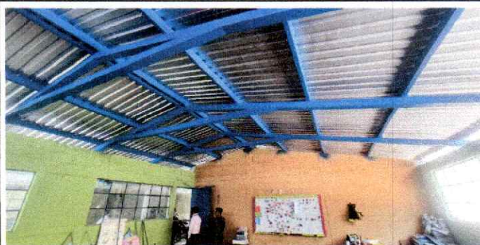
Foto 2: Se puede constatar el remozamiento de la estructura portante de metal en el módulo de aulas general. Se denota una aplicación uniforme de pintura anticorrosiva
