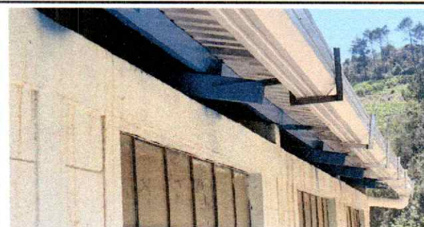
Foto 5: Se verifica la instalación de canales metálicos de alto caudal para la conducción de agua pluvial
