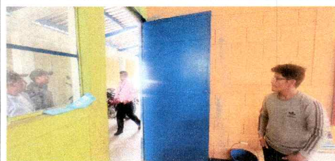
Foto 10: Se puede verificar la aplicación de pintura anticorrosiva en puerta de metal de módulo de aulas
