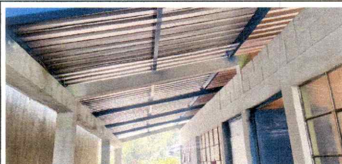
Foto 4: Se verifica la instalación adecuada de lámina troquelada calibre 26
