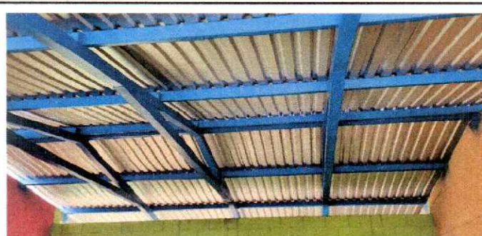
Foto 6: Se puede verificar la remozamiento de estructura portante de metal e instalación de lámina troquelada calibre 26 en aula 1.
