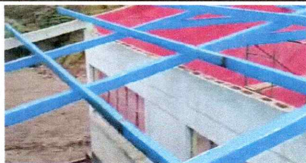
Foto 3: Puede verificarse el inicio del remozamiento de estructura portante de metal existente.
