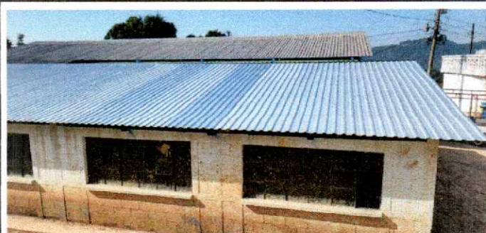
Foto 4: Se verifica la instalación de cubierta de lámina troquelada calibre 26 en módulo de aulas.
