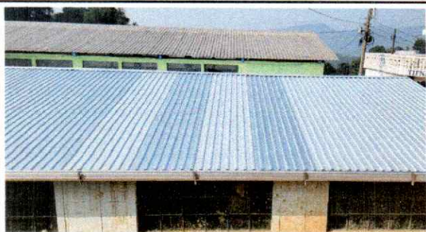
Foto 5: Se verifica la instalación de cubierta de lámina troquelada calibre 26 en módulo de aulas.
