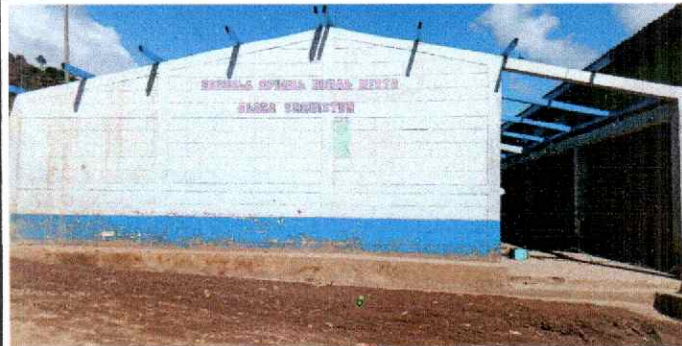
Foto 2: Puede verificarse el inicio de remozamiento para remover la cubierta de lámina existente.
