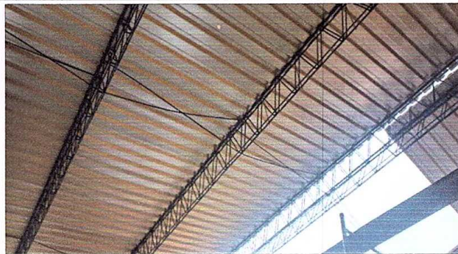
Foto 2: Módulo 1. Instalación de lámina troquelada aluzinc.
