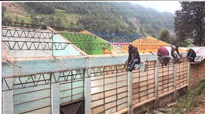
Foto1: Módulo 1. Sustitución de lámina duralita, por lámina troquelada aluzinc calibre 24.
