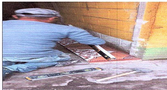
Foto 6: Módulo 2. Sustitución de piso de torta por piso cerámico.
