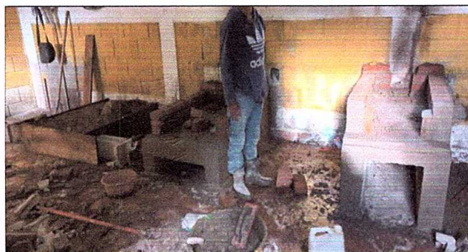
Foto 5: Módulo 2. Sustitución de estufa rural.
