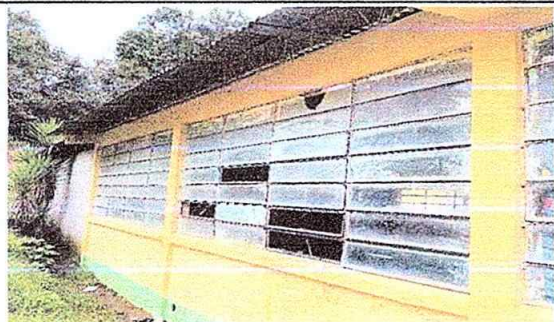
Foto No. 9. MODULO 4. Sustitución de vidrios
