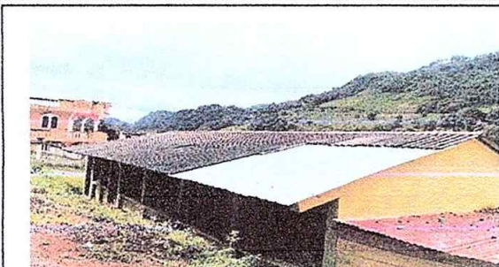
Foto No. 1. MODULO 1 sustitución de duralitas por laminas troqueladas
