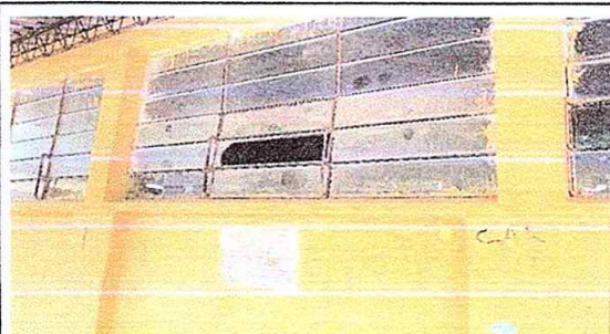
Foto No. 4. MODULO 1. Sustitución de vidrios
