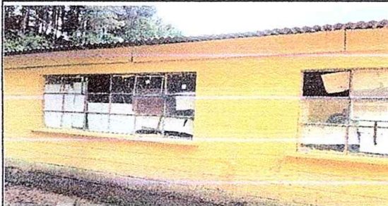
Foto No. 8. MODULO 3. Sustitución de vidrios
