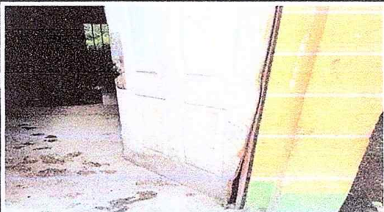
Foto No. 7. MODULO 2. Sustitución de puerta de madera por metal
