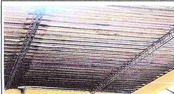
Foto No. 3. MODULO 1. Mantenimiento de estructura de metal
