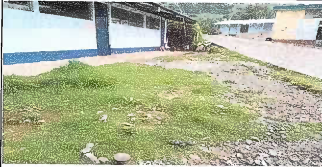
Foto 7: Sustitución de plancha de concreto
