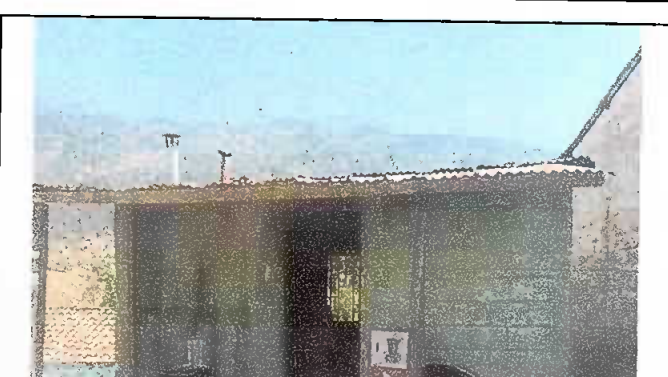
Foto 4: Sustitución de lamina por lamina troquelada y pintura en muros
