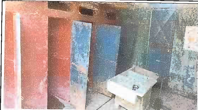
Foto1: Sustitución de puertas de sanitario, azulejos, inodoro, migitorio, grifos y accesorios
