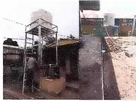
Foto 2: Sustitución de tinaco, reparación de base e instalación de tubería principal y distribución a sanitarios.
