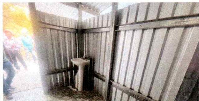
Foto 10: Se observa el mejoramiento de muros, con instalación de estructura portante de metal y lámina troquelada calibre 26 para cubierta y muros en baños generales.
