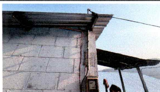
Foto 6: Se ha iniciado el mejoramiento de red eléctrica desde la acometida hacia el módulo de aulas.
