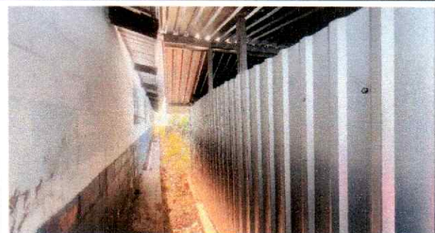
Foto 11: Se observa el avance del mejoramiento de muros, con instalación de estructura portante de metal y lámina troquelada calibre 26, en baños generales.
