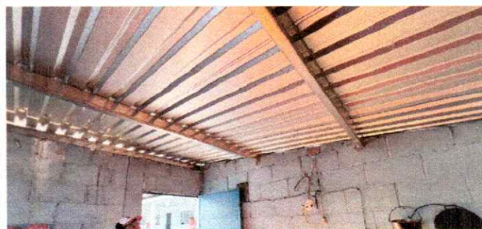
Foto 4: Se ha instalado la estructura portante de metal y cubierta de lámina troquelada calibre 26 en área de cocina.
