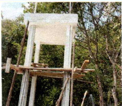
Foto 7: Se ha iniciado el mejoramiento de red hidráulica con la instalación de estructura para tinaco.
