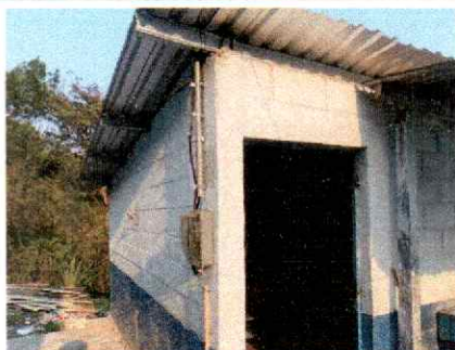
Foto 3: Se ha instalado la estructura portante de metal y cubierta de lámina troquelada calibre 26 en área de cocina.
