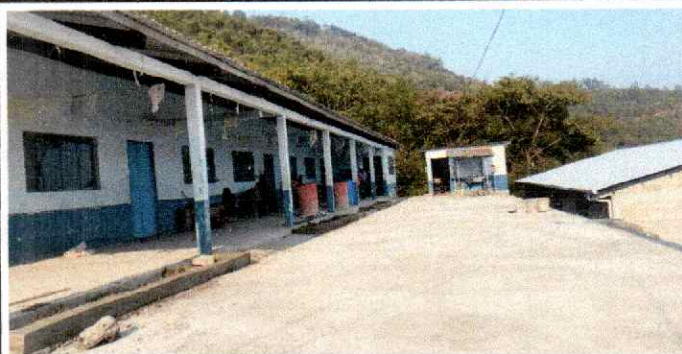
Foto 2: Puede verificarse el remozamiento en piso de torta de concreto en patio.
