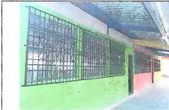
Foto 2: Módulo 1. Ventana, se observan tres aulas con nueve balcones de la parte de enfrente.
