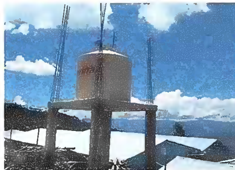
Foto 1: PATIO. Se observa la base de concreto finalizado para depósito de agua de 2,500 litros.
