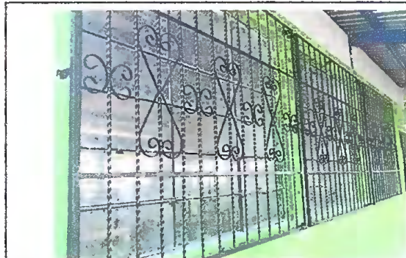
Foto 1: Módulo 1. Ventana, se observan balcones instalados en cada ventana de las aulas
