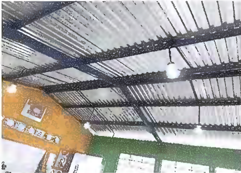
Foto 7: Módulo 1. Focos ahorradores, se observan cuatro focos instalados en cada aula.
