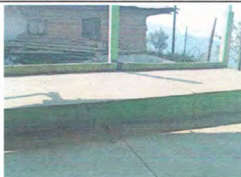
Foto 12: Modulo 4. Se observa que el escenario está agrietada y undida, requiere mantenimiento en su totalidad.
