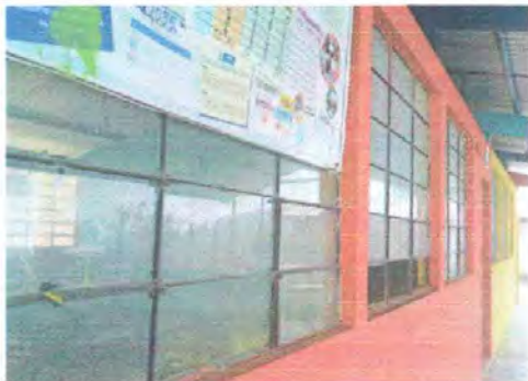
Foto 1: Modulo 1. Ventana, se observan tres vidrios rotos, lo cual presenta inseguridad, requiere instalación de vidrios y balcones.
