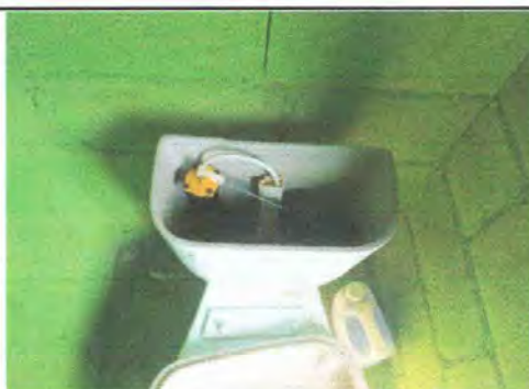
Foto 5: Modulo 3. Inodoro, se observa que esta sin uso el tanque por fisura.
