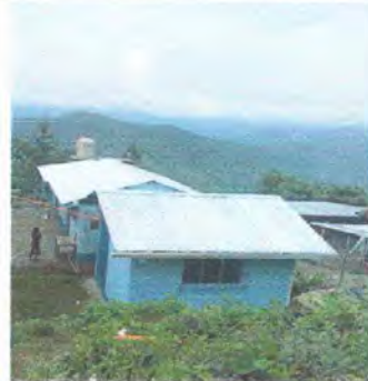
Foto 14: Patio. Se observa el depósito de agua a 15 metros de la cocina, la cocina está en desnivel; por lo que no se abastece, requiere instalación base nueva de depósito de agua de 2,500 lt exclusivamente
