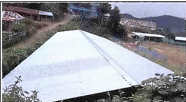
Foto 1: Módulo 1: Sustitución de lámina por lámina troquelada.
