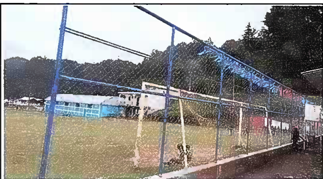
Foto 3: Módulo 1: Reparación de tubo hg y Malla galvanizada.
