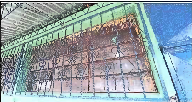
Foto 5: Módulo 1: Instalación de balcones de metal.
